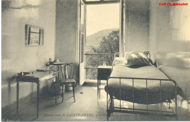
Figure V. 13. Salle de malades individuelle dans la maison hospitalière Le Sanatorium de Saint-Feyre. 1906
