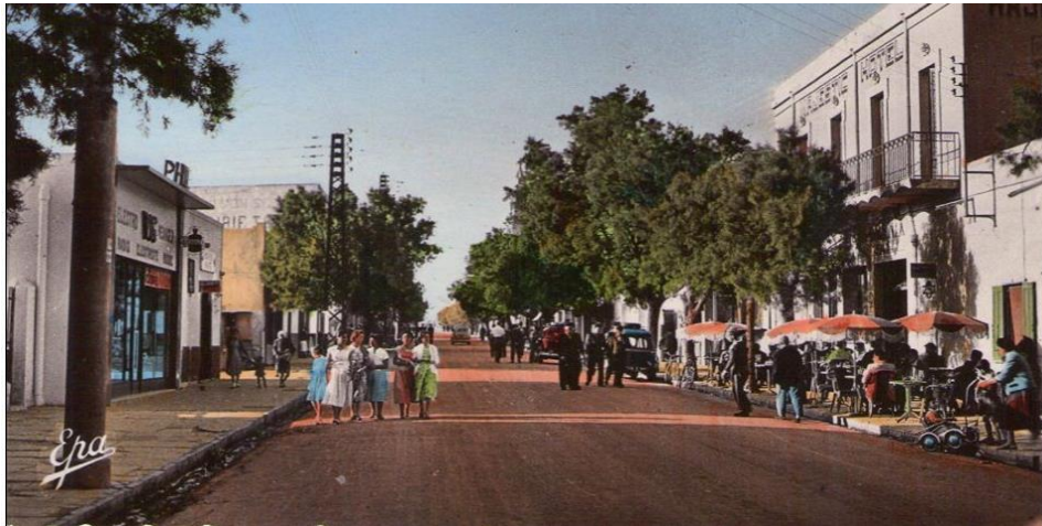
fig. n° 27 : La rue Raymond Poincaré actuellement boulevard colonel Lotfi. Source : APC de Béchar, 2014.
