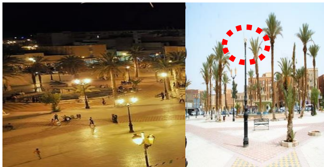
Photo. n° 06 : Des lampadaires ont été posés pour plus de sécurité. Mais il y a un manque d'entretien. Source : la chercheuse, 2016.
