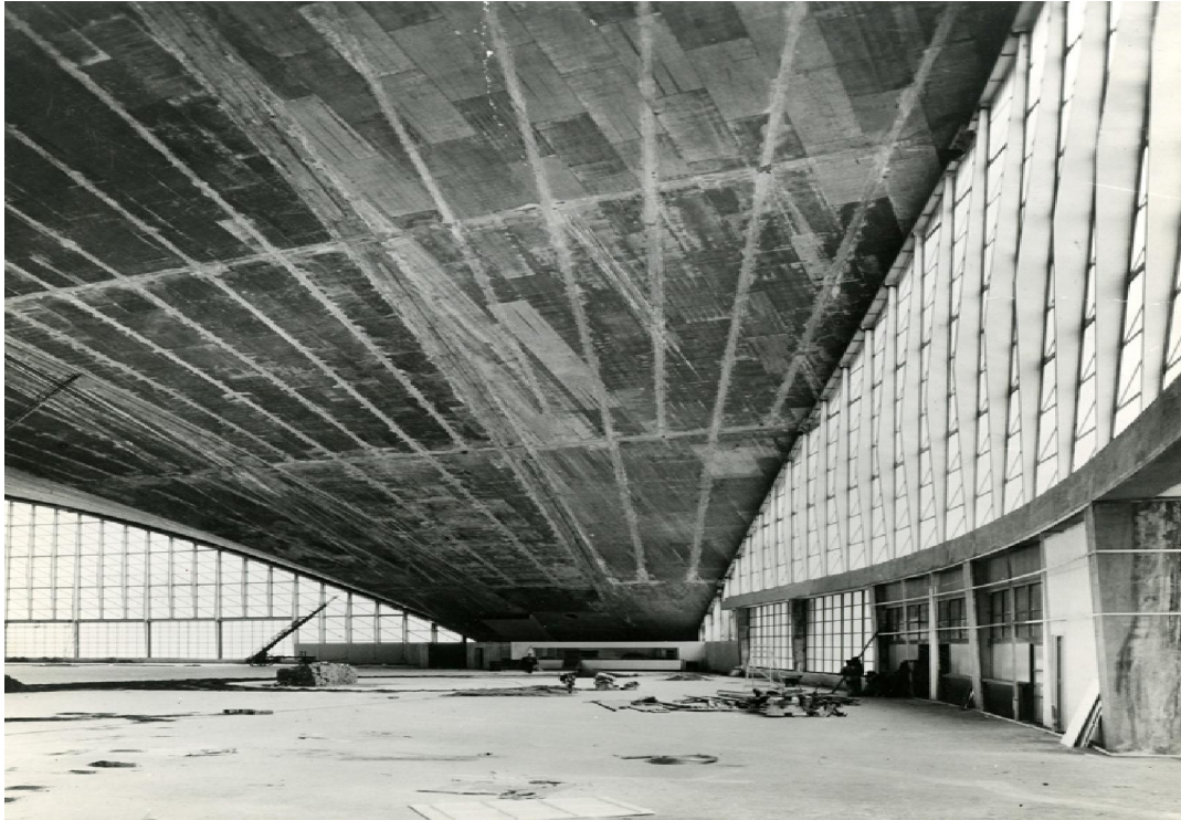
Fig.I.4. Palais des Expositions, Turin (Italie), Vue intérieure de chantier 4
