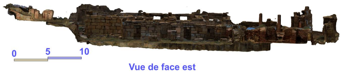
Figure,67 : vue de face est de la piscine et état majeur.
