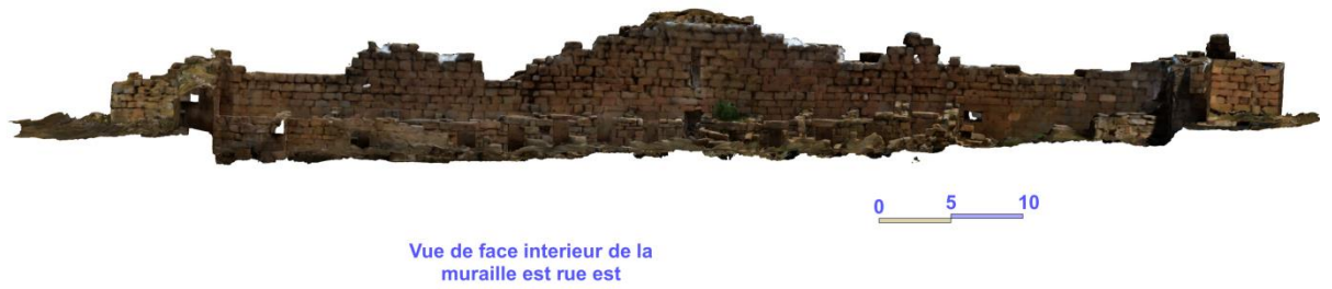
Figure 101 : vue de face intérieur de la muraille est produite par Agisoft photoscan
