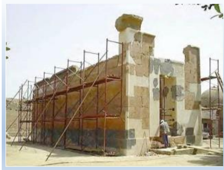
Figure 7 : La chapelle rouge de Karnak en cours de reconstitution. Source : (Selamli. 2012)
