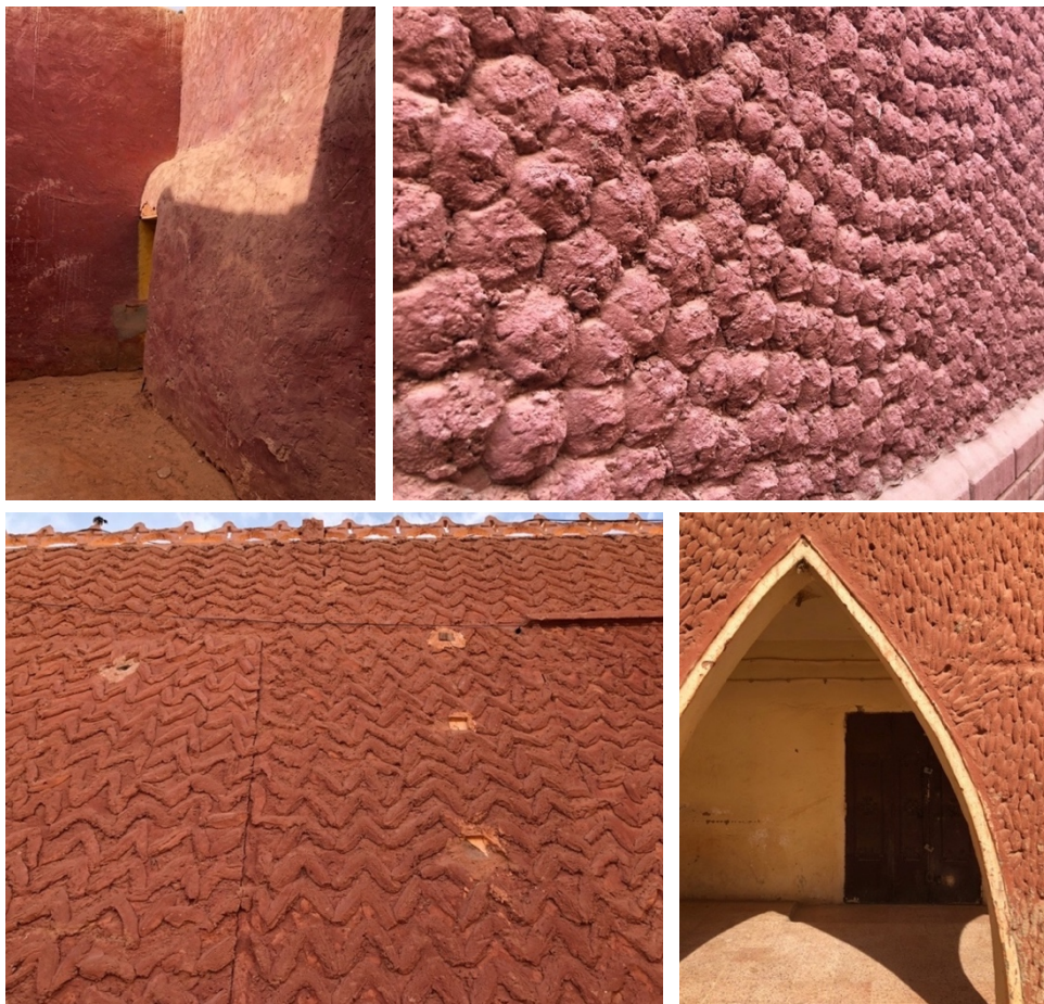
Figure VI- 32. Typologie des enduits extérieurs
