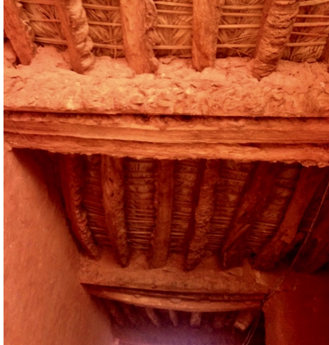
Figure VI- 15. Deux poutres sous forme d'assemblage des solives
