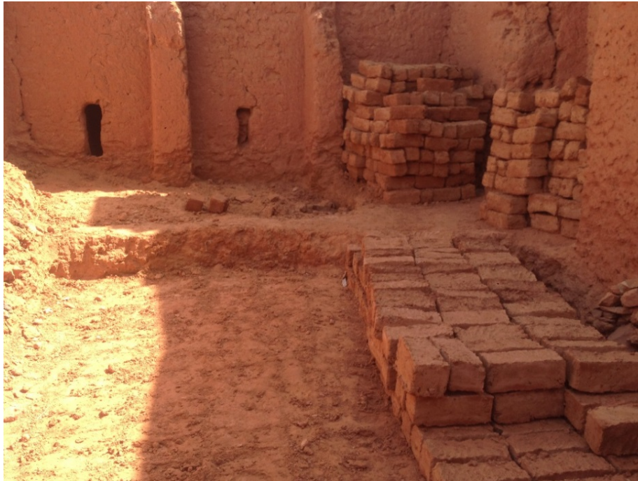
Figure VI- 5. Fosse de préparation du mélange pour l'adobe.
