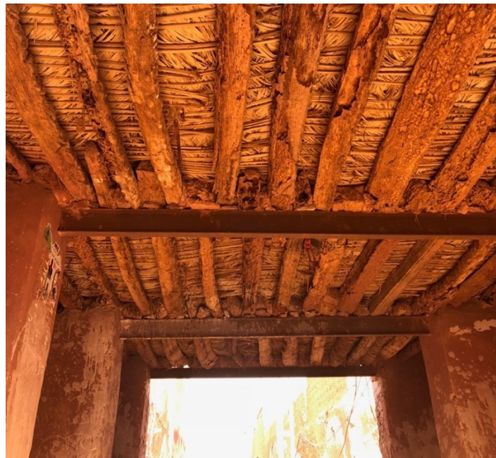
Figure VI- 16. Utilisation des poutres métalliques, avec les solives en bois de palmier, passage d'El Manjour dans le Ksar de Timimoun
