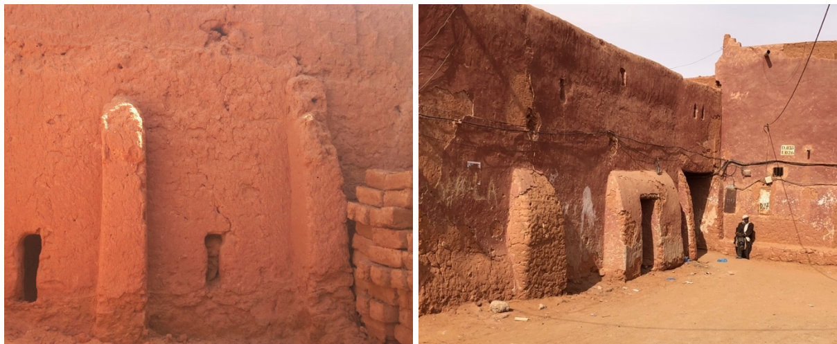
Figure VI- 18. Murs à contrefort dans le Ksar de Timimoun
