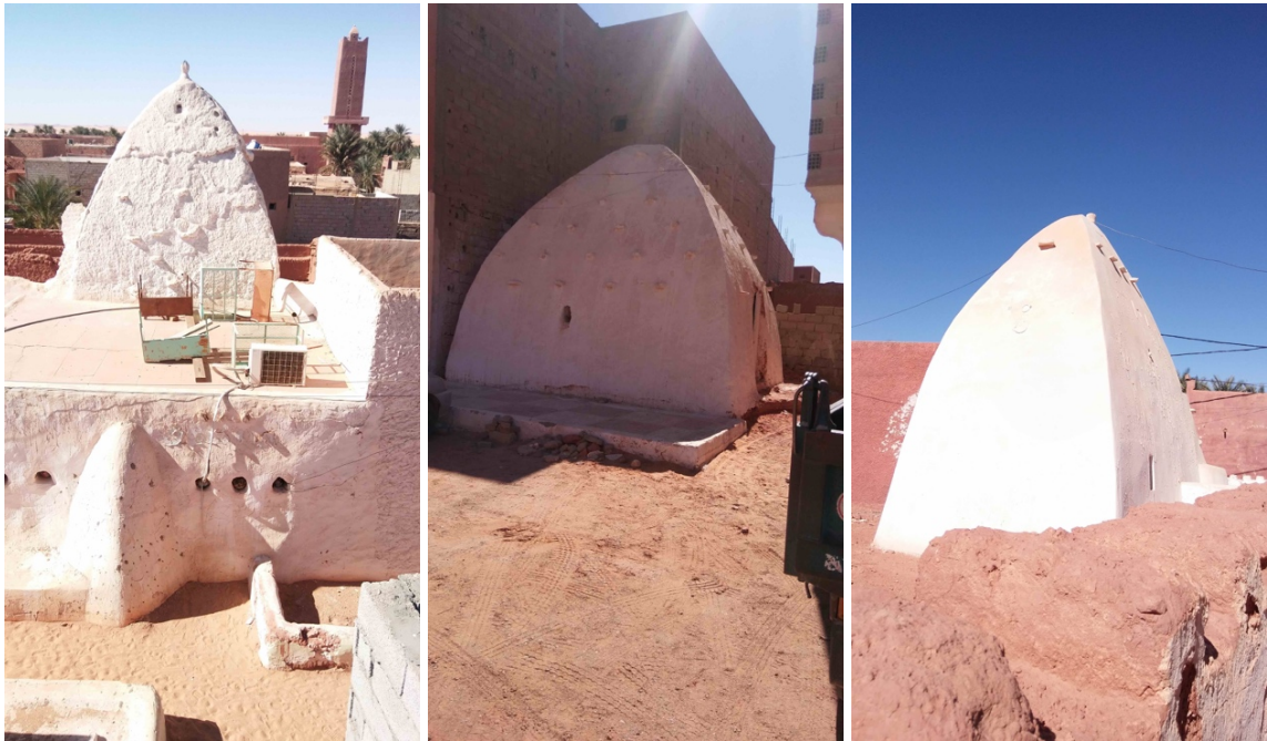
Figure VI- 22. Trois coupoles abritant des saints à Timimoun
