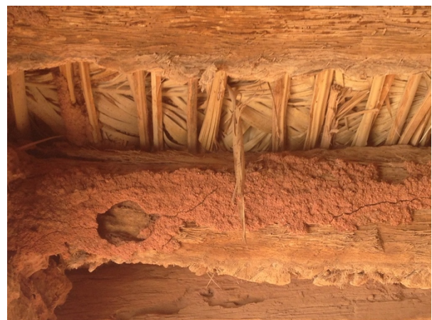
Figure VI- 38: Solive en bois de palmier attaquée par les insectes
