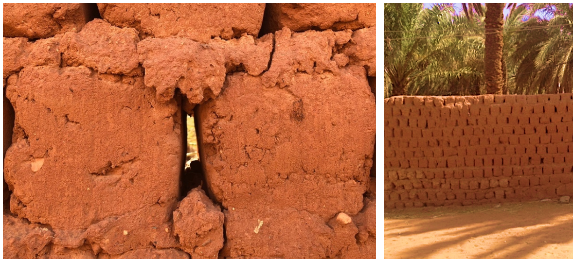
Figure VI- 36. Mur de clôture dans la palmeraie de Timimoun
