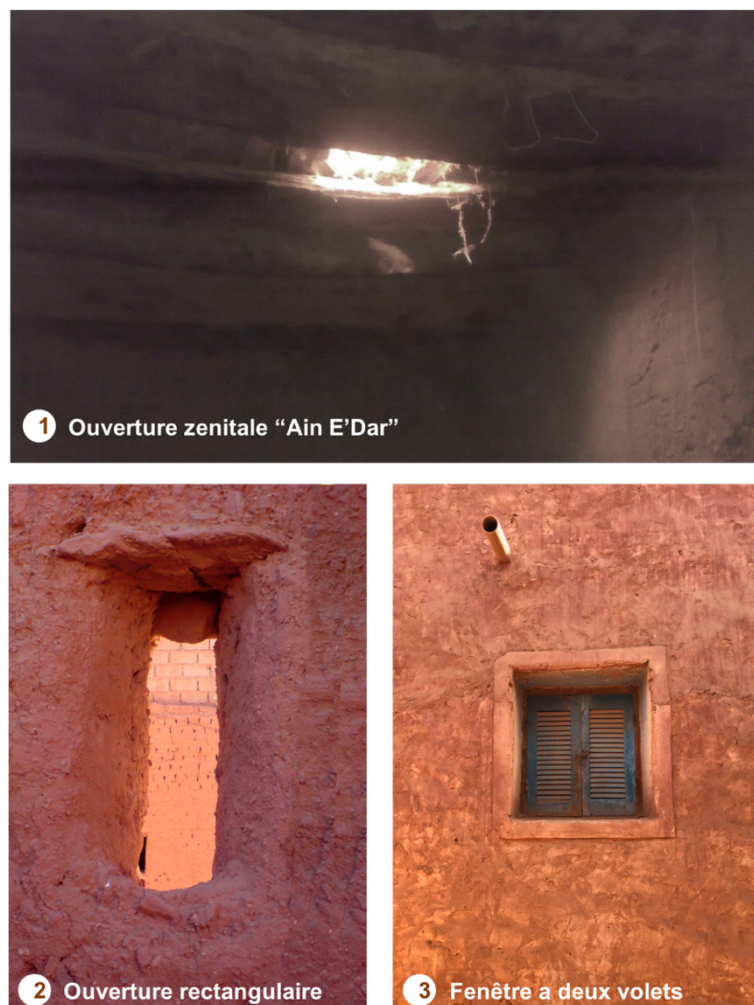
Figure VI- 31. Typologie des fenêtres
