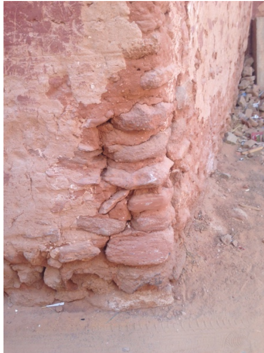
Figure VI- 37. Réparation d'un coin de mur
