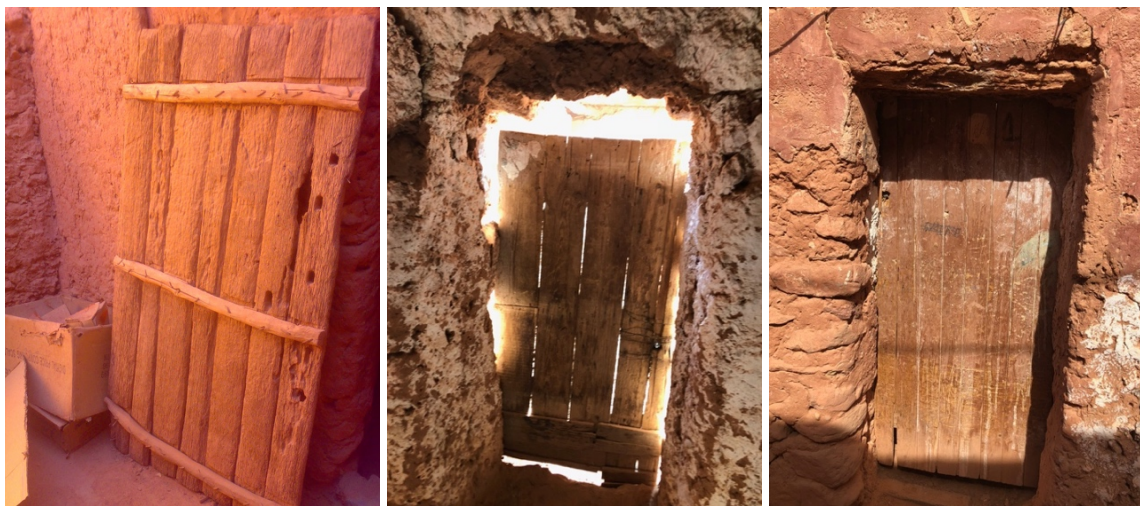
Figure VI- 29. Typologie des portes à Timimoun
