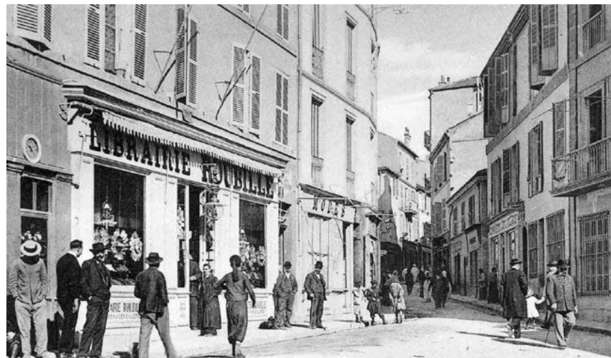
Figure 8-7 : Photo de la rue Damrémont, Constantine entre 1897 et 1930. (BnFGallica, 2016)
