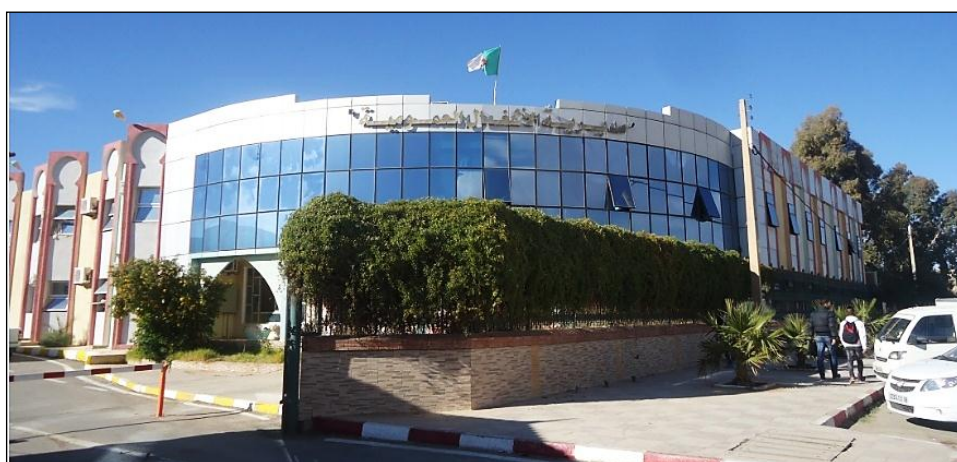
Figure III.33: façade principale du bâtiment DTP.(source auteur, 2016).
