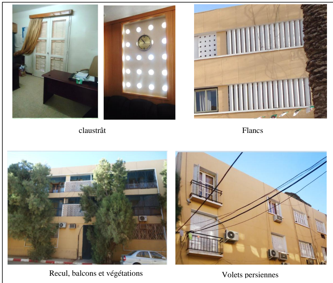
Figure III.20 : les différents systèmes utilisés de protections des ouvertures (siège APC), (Source : auteur, 2017).
