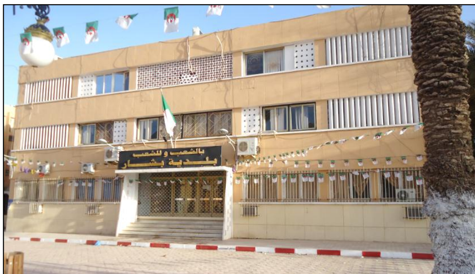
Figure III.17: vue sur la façade principale (APC). (Source : Auteur, 2017).
