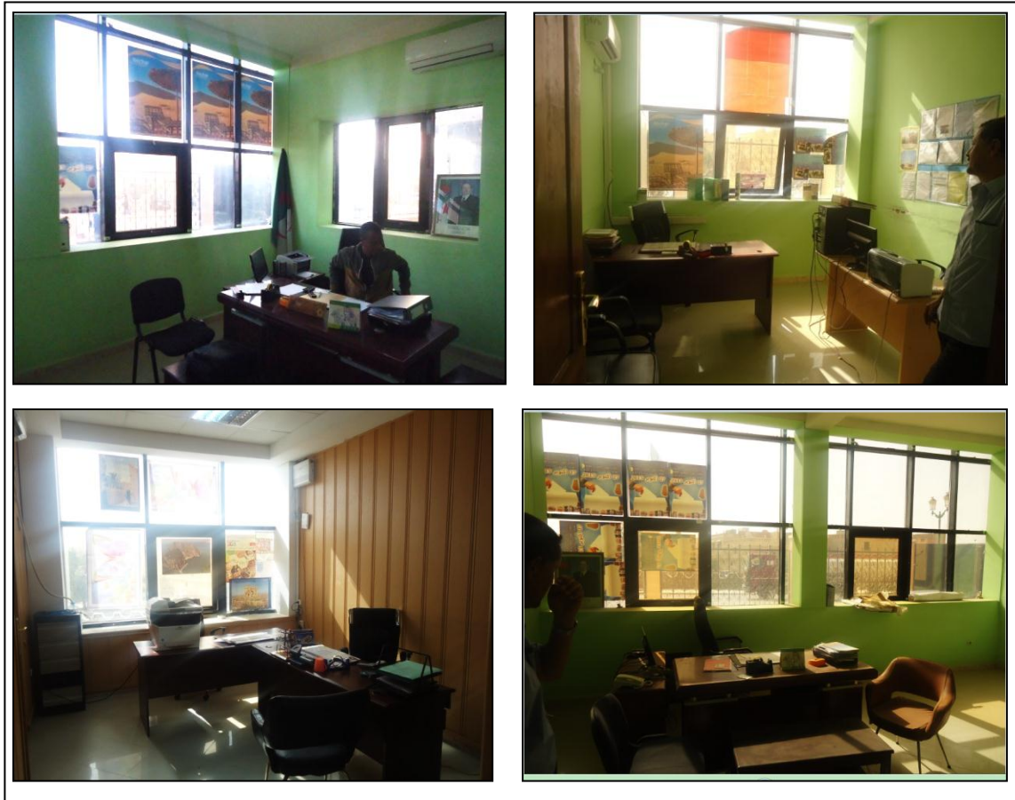
Figure IV.35: Le collage du papier sur le vitrage comme conduite comportementale répandue chez les usagers. Bâtiment Tourisme.
