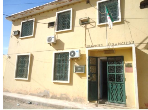
La façade Nord-est de l'immeuble avec son accès.
