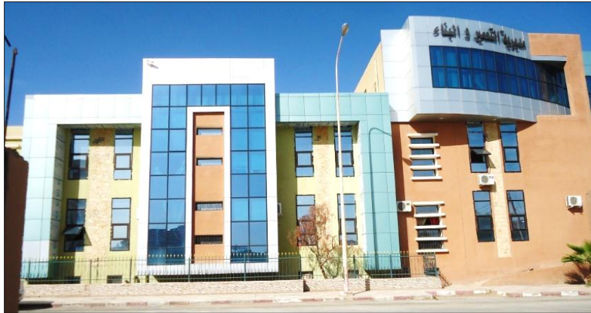
Figure III.38: Façade Sud-sud-ouest du bâtiment DUAC. (source auteur, 2017).
