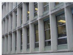
Figure II.31: protection extérieur mobile et protection fixe (Source : C. Alain, 2012)
