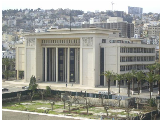
Figure 1. 15 Le foyer civique d'Alger, Léon Claro, 1927-1935, prémices de l'architecture moderne en Algérie. source (mapio)
