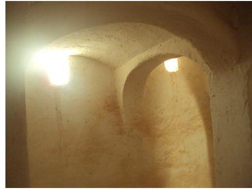
Figure 3. 6 Exemple de fenêtres donnant sur l'extérieur, depuis Ghardaïa, source Auteur
