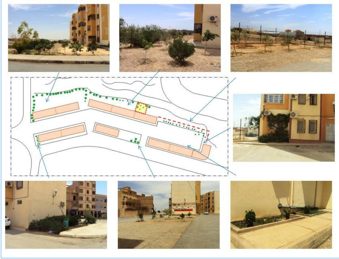
شكل رقم (147): حيازة مساحات خضراء (مبادرة جماعية) في حي 110 مسكن تساهمي طريق باتنة
