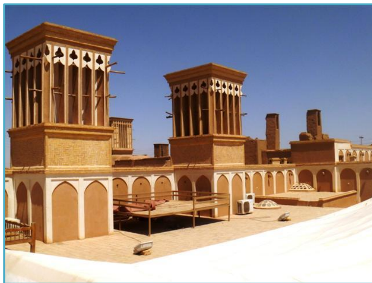
Fig.I.23 : tours a vent dans les bâtiments passivement dans l'architecture Iranienne. ( http://www.petitfute.com/p174-iran/guide-touristique/c113114-arts-et-culture.html ) 13 avril 2015
