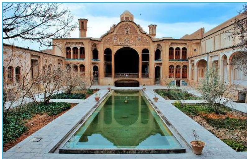
Fig. I.17 : La végétation est pressante avec une surface d'eau pour l'humidification de l'air. Patio de la maison des Boroudjerdi Kashan.
