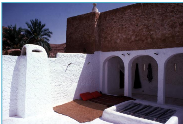
Fig. I.16 : Les galeries d'arcade et des murs acrotère assure l'intimité et une protection de rayon solaire dans l'architecture mozabite.
