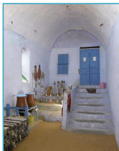
Fig.1.18 : Maison en Égypte, dans la région d'Assouan. Les deux gargoulettes sont positionnées sous la fenêtre, au niveau du flux d'air. Le sol enterré par rapport à l'extérieur, pour valoriser la fraîcheur de l'inertie terrestre.
