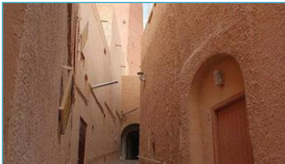
Fig. I.11 : Traitement de la surface des maisons crépi dans le ksar de ben-Isgan.
