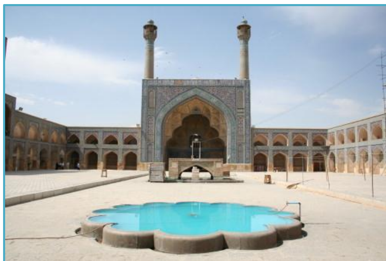
Fig. I.15 : Iwan dans la mosquée d'Ispahan Iran ou montre l'exemple l'effet d'ombre qui protège la bâtisse de rayon solaire.
