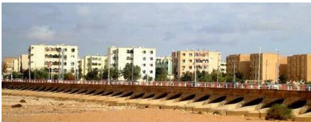
Figure 60 : L’extension de Biskra ( El Alia) vue du pont.
