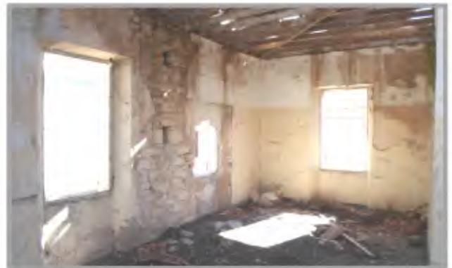
Photo V-11: Fissures profondes, éventrement de la maçonnerie
