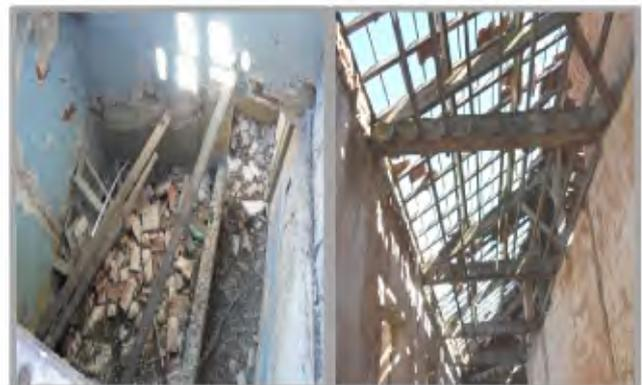
Photo V-12: Toiture détériorée et planchers effondrés.
