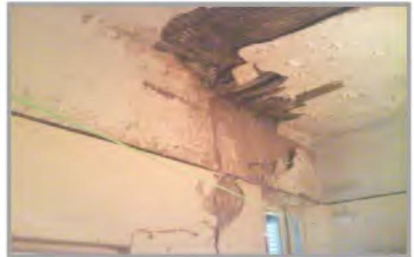
Photo V-08: Fissures passantes, éventrement de la maçonnerie
