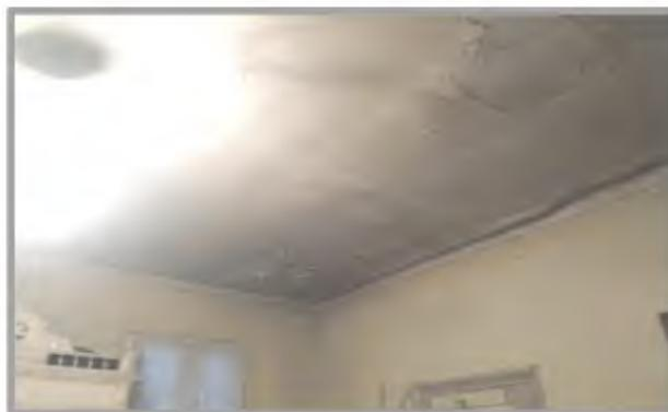
Photo V-05: Infiltrations des eaux pluviales, humidité,...
