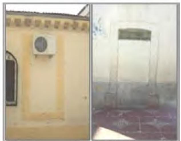
Photo VII-02: Suppression d'une porte et d'une fenêtre
