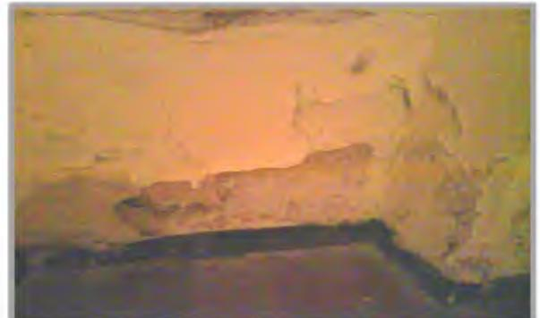
Photo V-09: Gonflement du mur et remontée capillaire
