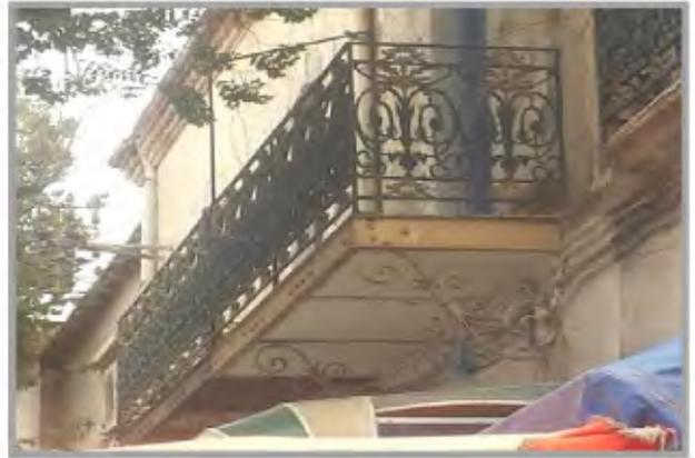
**Photo IV-27: Balcon en encorbellement**
