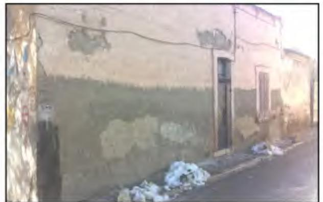
Photo VII-01: Revêtement de la façade avec du mortier
