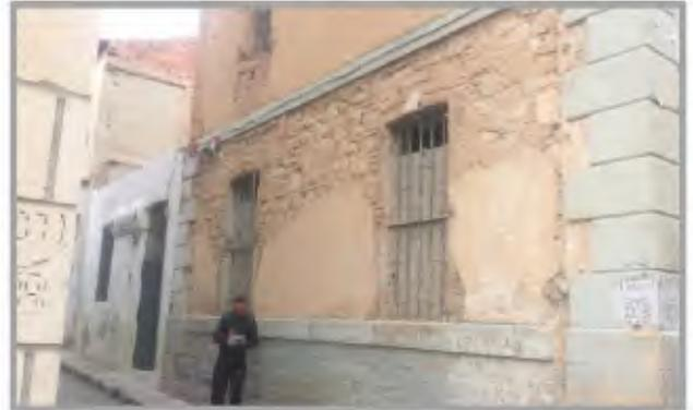
Photo V-10: Désolidarisation de la maçonnerie, détachement des chambranles, ..../ Source : auteur, 2014.
