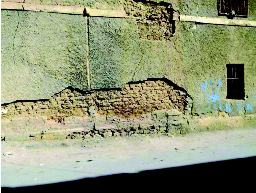
صورة 7.4 جدران خارجية مبنية بالطوب الطيني المصدر: صاحب المذكرة
