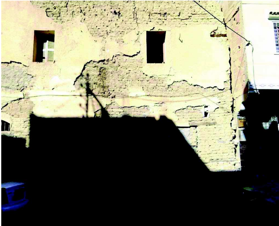
صورة 6.4 جدران خارجية مبنية بالطوب الطيني المصدر: صاحب المذكرة
