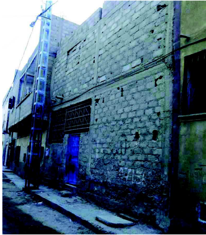
صورة 11.4 جدران خارجية مبنية بالطوب المملوء المصدر: صاحب المذكرة
