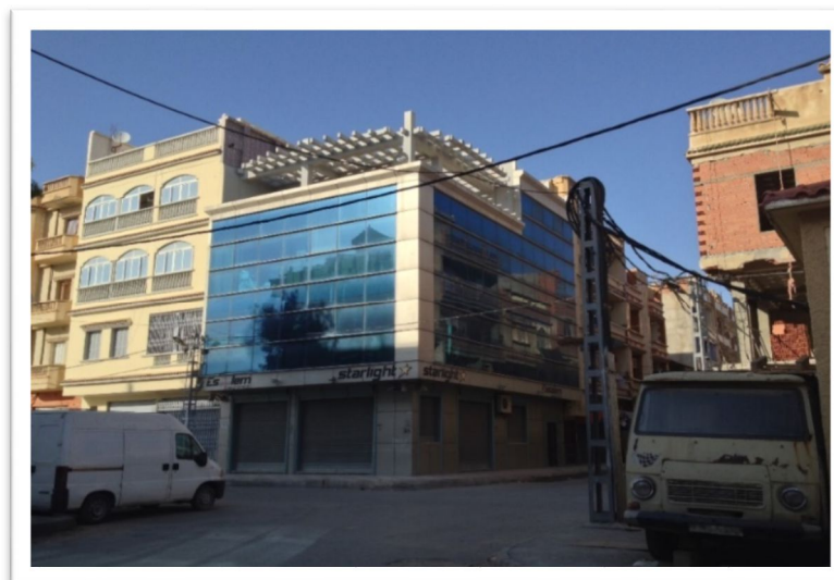
Figure I.11. Immeuble à matériau réfléchissant.
