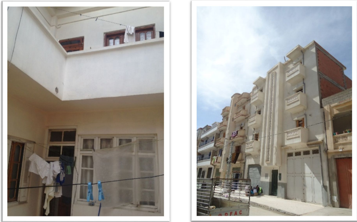
Figure IV.1. Vues extérieures d'une habitation. Source : Auteur
