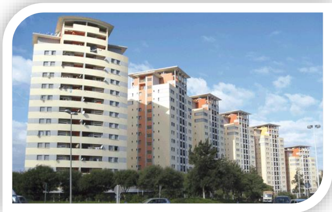
Fig 38: Logements AADL, Alger (Source : AADL)
