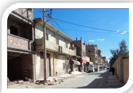
Fig 277 : Photo d'une rue (Rassauta Est)
