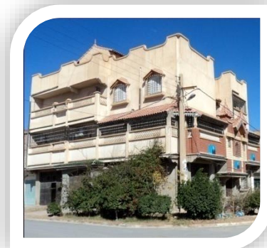
Fig 304 : Logts Individuel transformé (Photo : Auteur)
