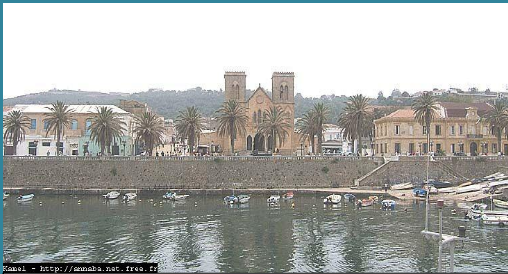
صورة رقم 06-5 واجهة من العمارة ذات النمط الأوروبي لتغطية و حجب النسيج القديم بمدينة القالة . المصدر: الباحث.
