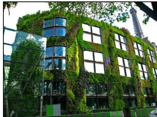
Fig. n°II.32 : mur végétal musée du quai, Branly, Paris. Source : http://www.murvegetalpatrickblanc.com
