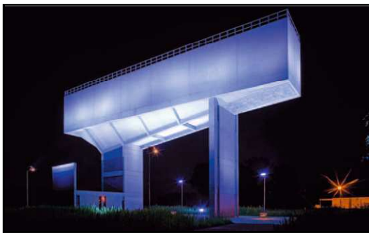
Fig. n°I.14 : Château d'eau pensé comme un bâtiment par Philippe Madec.
