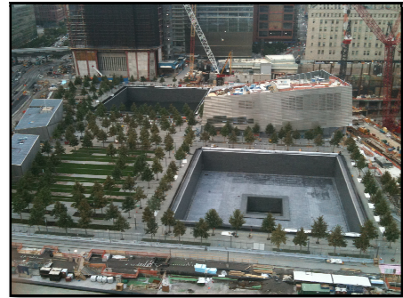
Fig. n°I.33 : deux percements, lieux des deux chutes d'eau perpétuelles - source : http://www.dezeen.com/
