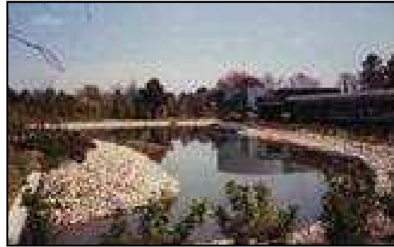
Fig. n°II.36 : Bassin de retenue, France Source : Degrotte. V, 2006
