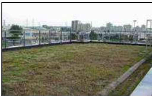
Fig. n°II.28 : Terrasse végétale. Source : Degrotte, V, 2006
