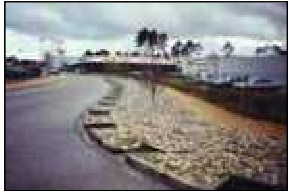
Fig. n°II.39: tranchées drainantes. Source : http://www.hqe.guidenr.fr
