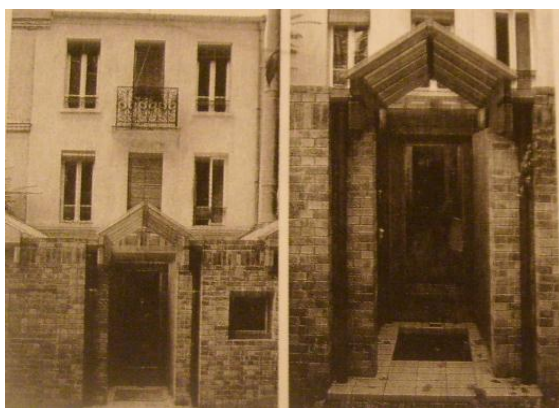
Fig. 4.78. Marquage de l'entrée Extension d'u pavillon, Paris, D. Spinetta arch., 1978, l'entrée Source : Donnadieu, B., 2004
