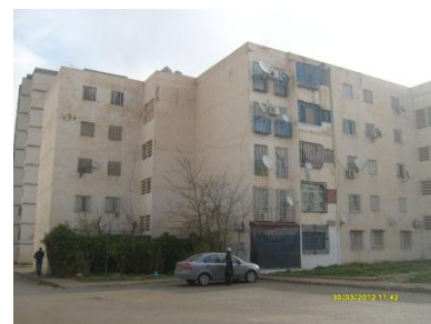
Fig. 2.22. Immeuble collectif -1200 logements – Batna-
