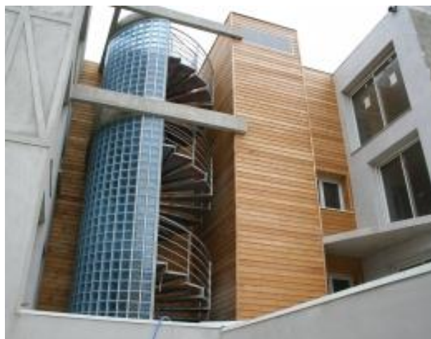
Fig. 4.79. Cage d'escalier moitié découverte ; bon éclairage et meilleure perception de l'ascension Immeuble le Belem à Wimereux
