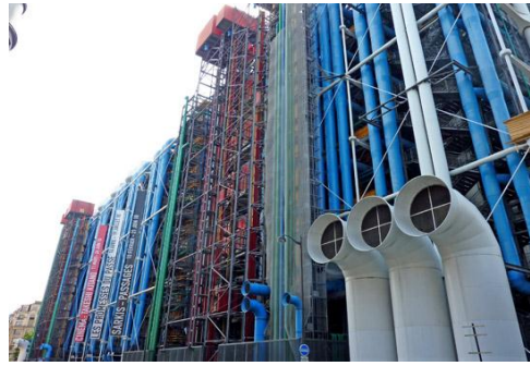
Fig.3.48. Le centre multiculturel George Pompidou, Les gaines techniques
