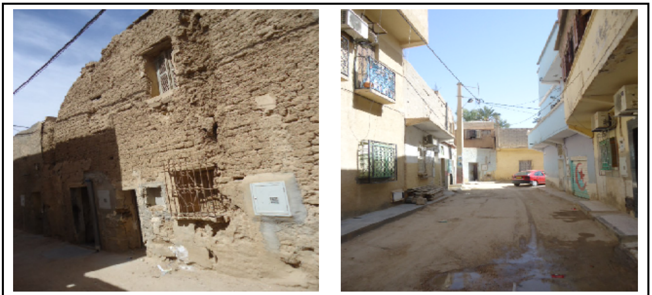
Photo5-(5,6) : Les matériaux de construction utilisés dans le quartier Msalla avant et après 1969
