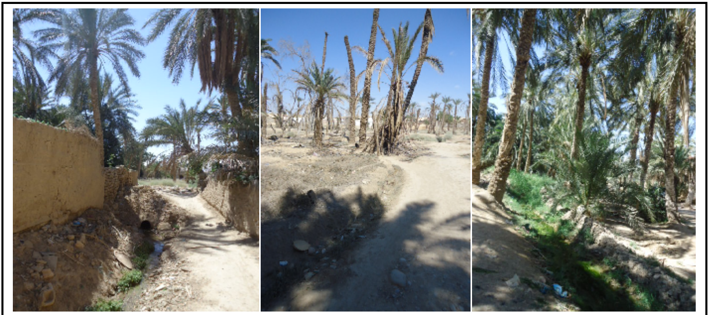
Photo4-(6, 7,8) : Des seguias dégradées à Gueddacha
