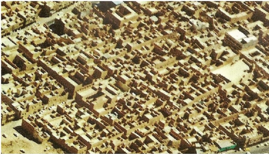
الصورة (5-10) النسيج العمراني القديم في عمران المدن الصحراوية
