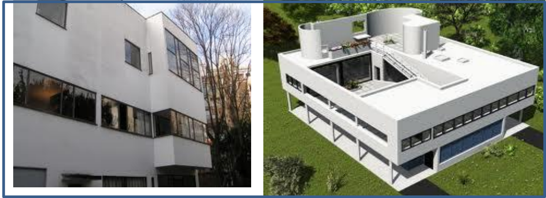
Figure III- 04 Présentation de la fenêtre en bande
