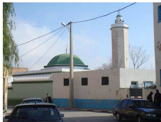
Figure 120 : La face extérieure des ouvertures, la salle de prière de la Mosquée Ayn El-Beida de Mascara. Source : (Belakehal, 2009).
