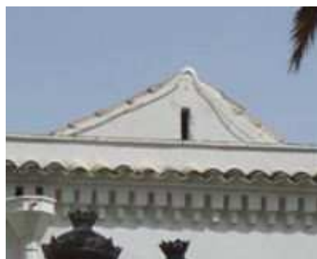
Figure 111 : La face extérieure de l'ouverture à profil variable au niveau du mur de pignon, la salle de prière de la Grande Mosquée de Tlemcen.
