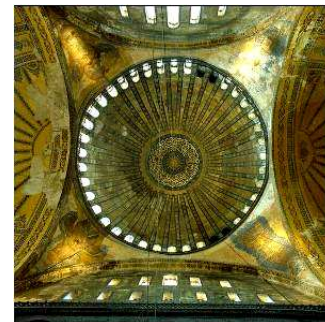
Figure 11 : La coupole de Sainte-Sophie a un diamètre de 32 mètres et culmine à 65 mètres de hauteur. On voit ici l'amorce des deux demi-coupoles qui l'épaulent. Grâce au nombre élevé des baies, la lumière se diffuse largement à l'intérieur de l'édifice.
