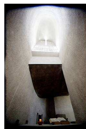
Figure 36 : Un espace interstitiel entre les murs et la voûte de béton permet à la lumière de passer ce qui allège visuellement la masse du couvrement.
