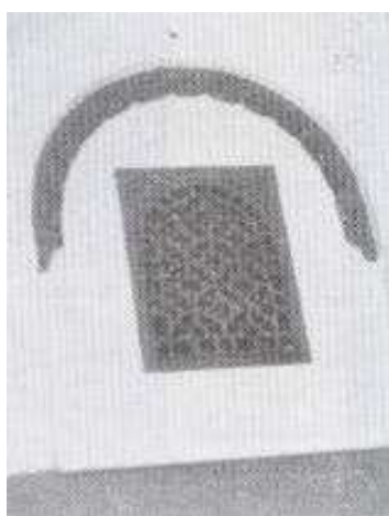
Figure 85: Claustrum du mur sud, à droite du mihrab.
