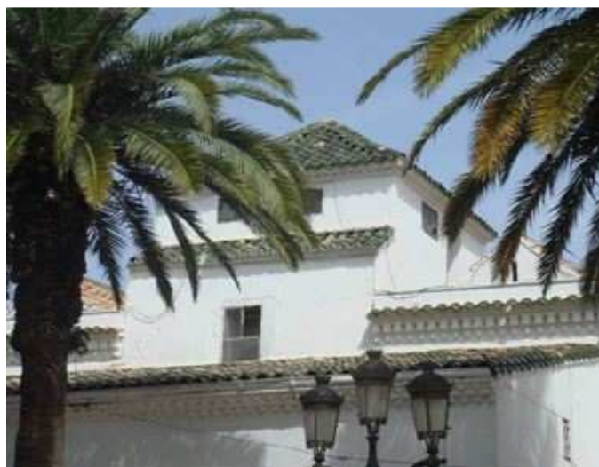
Figure 114 : La face extérieure des ouvertures de la coupole devant le mihrab de la Grande Mosquée de Tlemcen.
