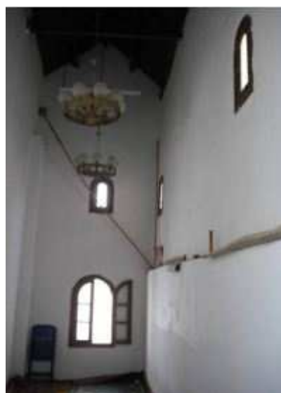
Figure 99 : Les fenêtres de la galerie précédant la cour, la Grande Mosquée de Nédroma.
