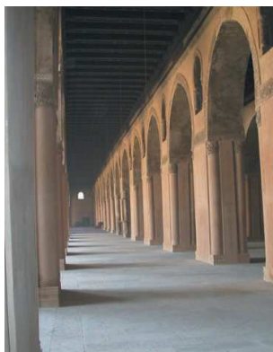
Figure 18 : Les portiques forment une succession d'arcs à peine outrepassés dont les intervalles sont percés d'une fenêtre reproduisant le même dessin.
