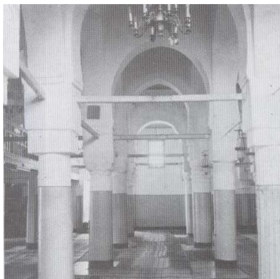
Figure 91 : Fenêtre correspondante à la cinquième travée. Source : (Bourouiba, 1983)
