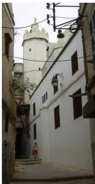
Figure 132 : Vue extérieure du côté du mur du mihrab de la Mosquée Safir d'Alger.
