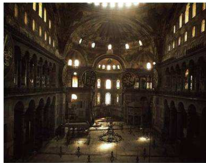
Figure 10 : Vue intérieure vers l'abside de la basilique Sainte-Sophie. On remarque les voûtes en cul-de-four et deux des quatre pendentifs sur lesquels repose la coupole.
