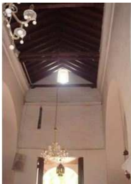
Figure 110 : Ouverture à profil variable au niveau du mur de pignon, la salle de prière de la Grande Mosquée de Tlemcen.
