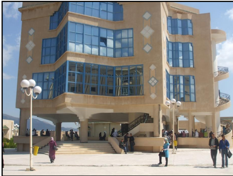
Fig. n°52 : Bâtiment en étoile sur pilote contenant la bibliothèque de la faculté des lettres. (Source : auteur).
