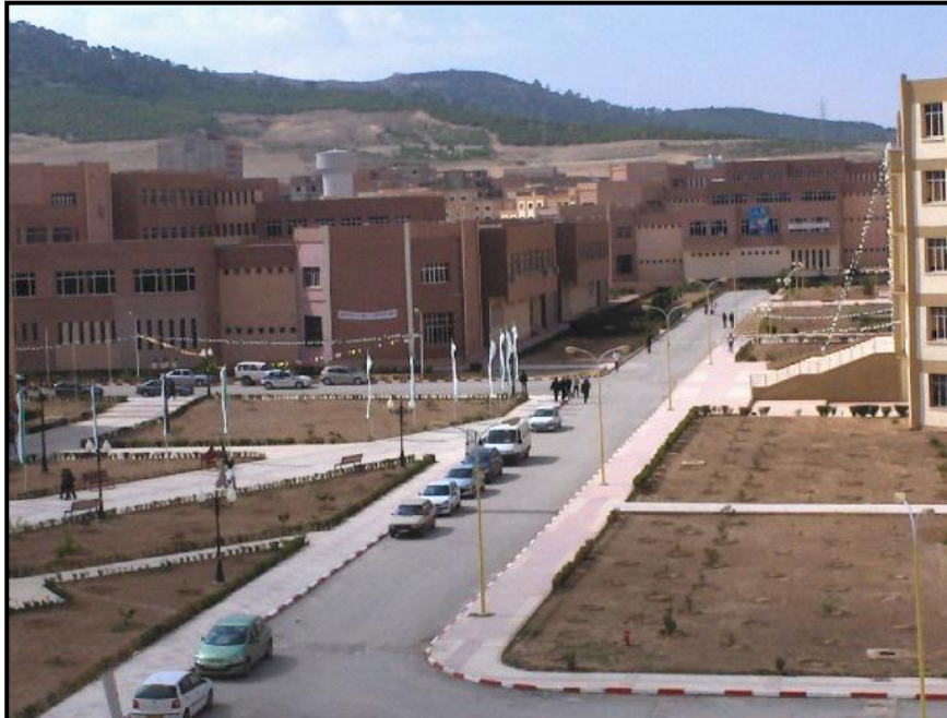
Fig. n°48 : Vue sur les bâtiments du noyau central 01 (Bâtiment de l'agronomie à droite, des sciences au fond et celui d'informatique à gauche). Source : http://www.panoramio.com/photo/2417242 , (2007).
