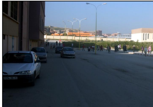
Fig. n°45 : Voirie mécanique. (Source : auteur).
