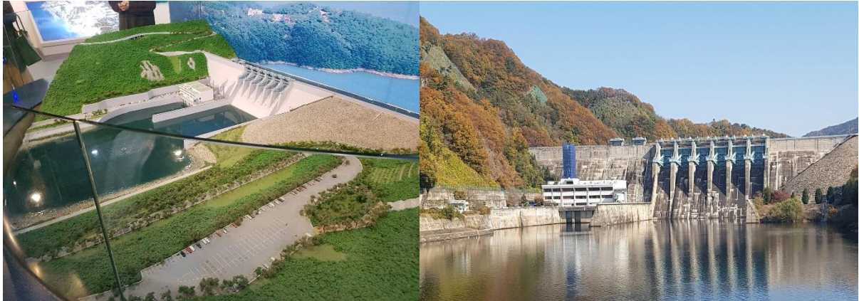
Figure 3.1 : Photographies du barrage Daecheong (Corée du sud), a) maquette du barrage, b) vue en aval du barrage
