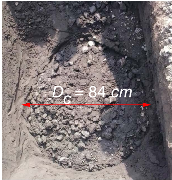
Figure 3.7. Vue sur la colonne ballastée après un dégarnissage en tête jusqu'à 1 m de profondeur.
