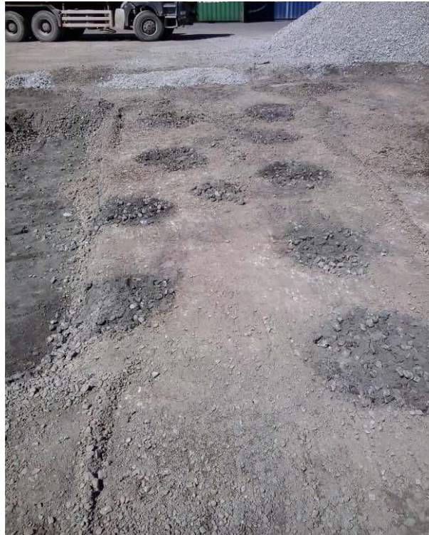
Figure 3.6. Planche d'essai après installation des colonnes.
