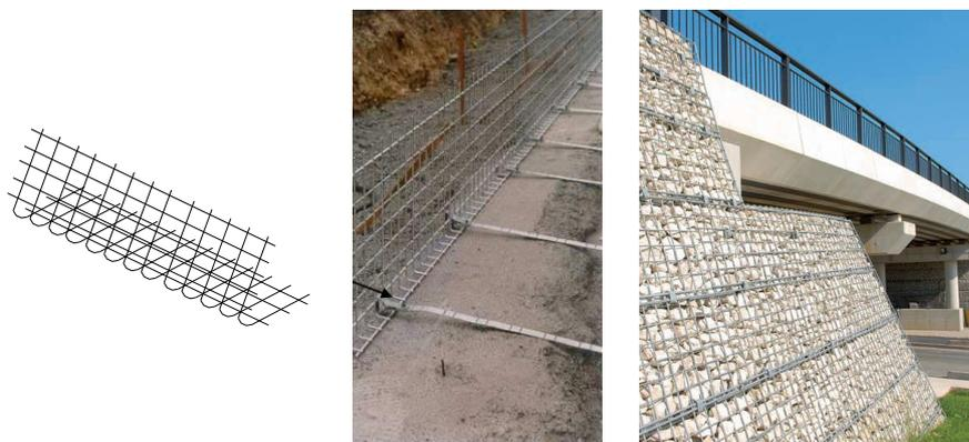
**Figure 1.14** Treillis soudé en acier
