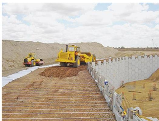
**Figure 1.20** Chantier de montage de murs en sol renforcé (Terre Armée)
