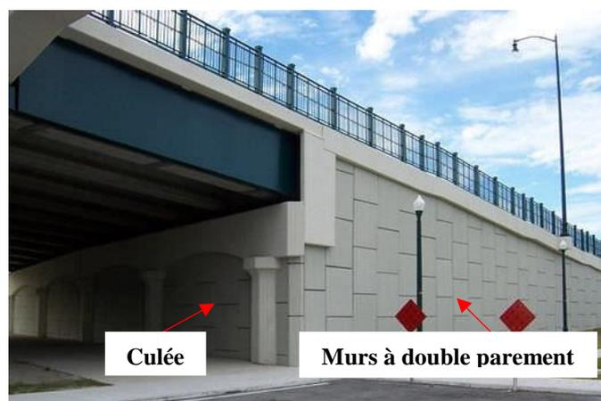
Figure 2.2 Culée en sol renforcé et murs à double parement
