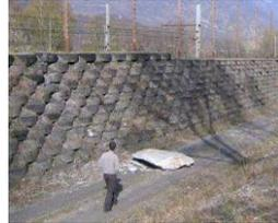
**Figure 1.16** Parement en Pneusol
