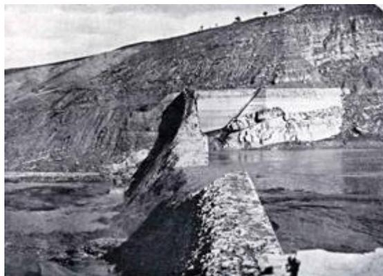
**Figure 116** Barrage de Fergoug après la rupture en 1927 (Comite technique permanent des Barrages, 1998, in : Bouhlali, 2006)
