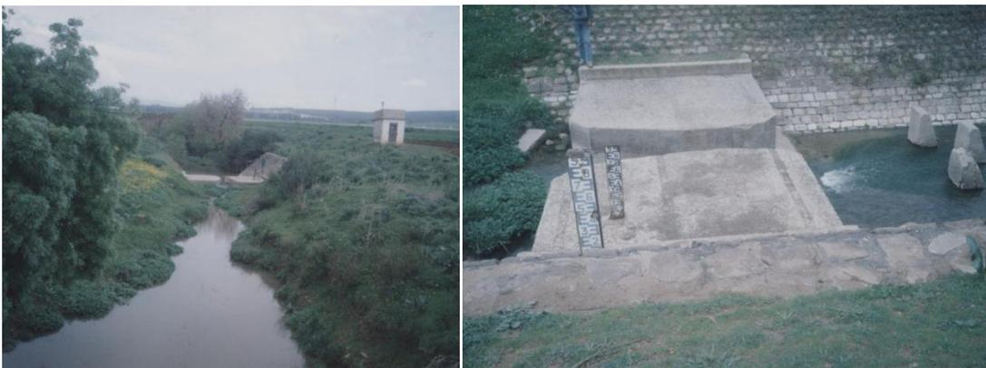
Figure 55 Station Ain Berda sur le bassin de l'Oued Ressoul : Station mise en service en 1958, en bon état et fonctionne correctement : canal et échelle en bon état, équipement automatique opérationnel : Situation au 1<sup>er</sup> Juin 2007 (Beloulou et al., 2008)
