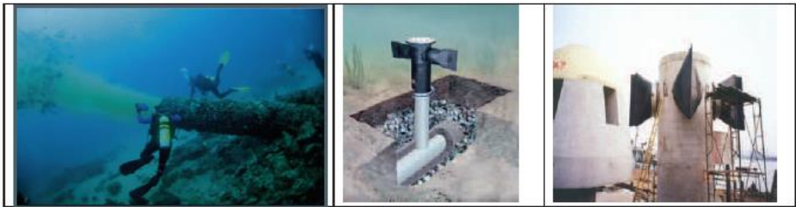
Figure V .2: (A gauche) (a)Emissaire marin avec un simple port (Steve Spring, Palm Beach County Reef Rescue 2011). (Au milieu) (b) Orifice avec un riser de deux ports en forme de T équipés des valves anti-retour. (A droite) (c) Installation des risers pendant la construction de l'émissaire –Californie. Les risers sont équipés d'arrangement des ports en forme de rosette,avec des valves anti-retour. (Bleninger, Jirka, 2010) et (Lee et al. 2001)
