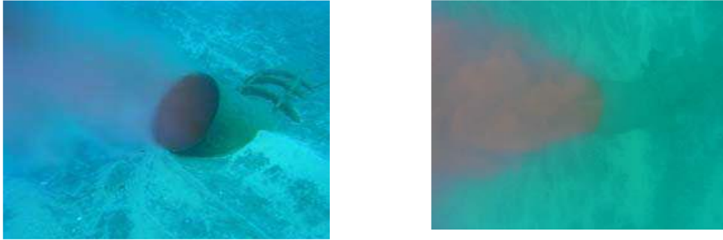
Figure IV .15: Photo pour un de rejet sous marin de la saumure (Bleninger et Jirka, 2010)
