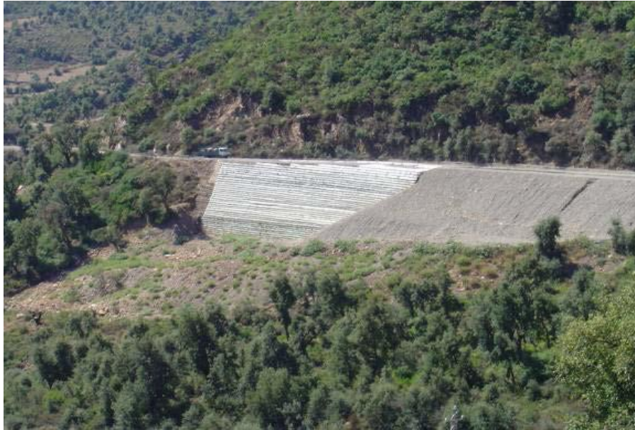
Figures 1.7.b vues de l'ouvrage en cours de construction et achevé
