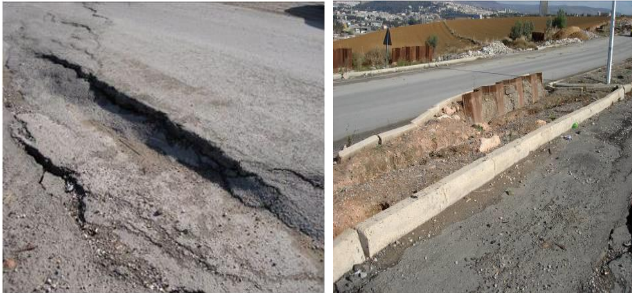
Figure 1.20 Palplanches ancrées dans le milieu de l'axe de la route
