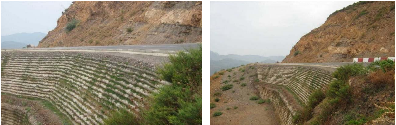
Figure 1.9.b ouvrage après son achèvement
