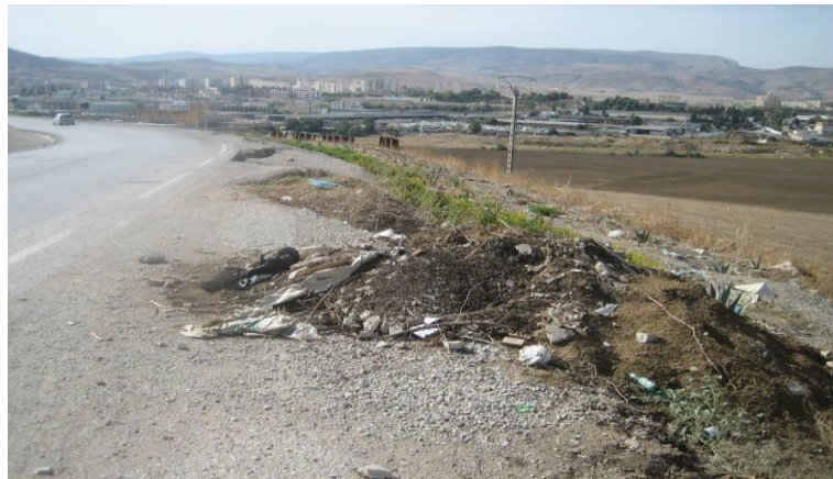
Figure 1.18 glissement au niveau de talus
