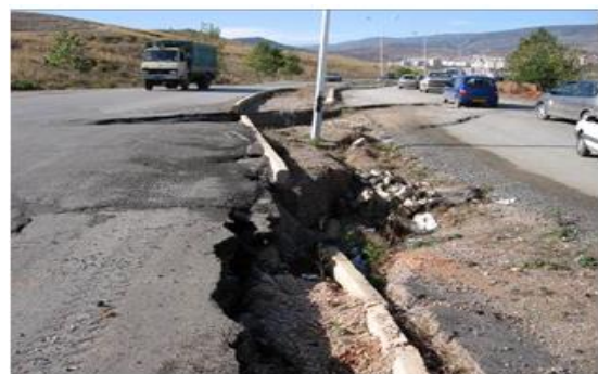
Figure 1.19 présence de faille au niveau de la route
