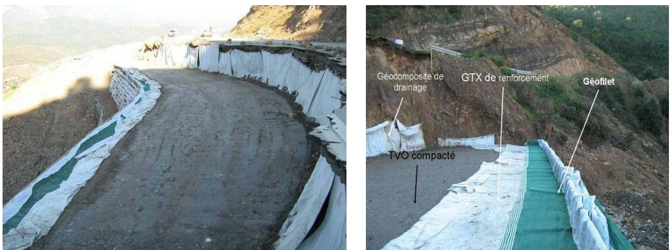
Figure 1.9.a ouvrage pendant la phase des travaux
