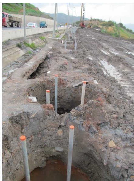
Figure4.24 Ligne de pieux (tronçon Buira-Alger, Mars 2014).
