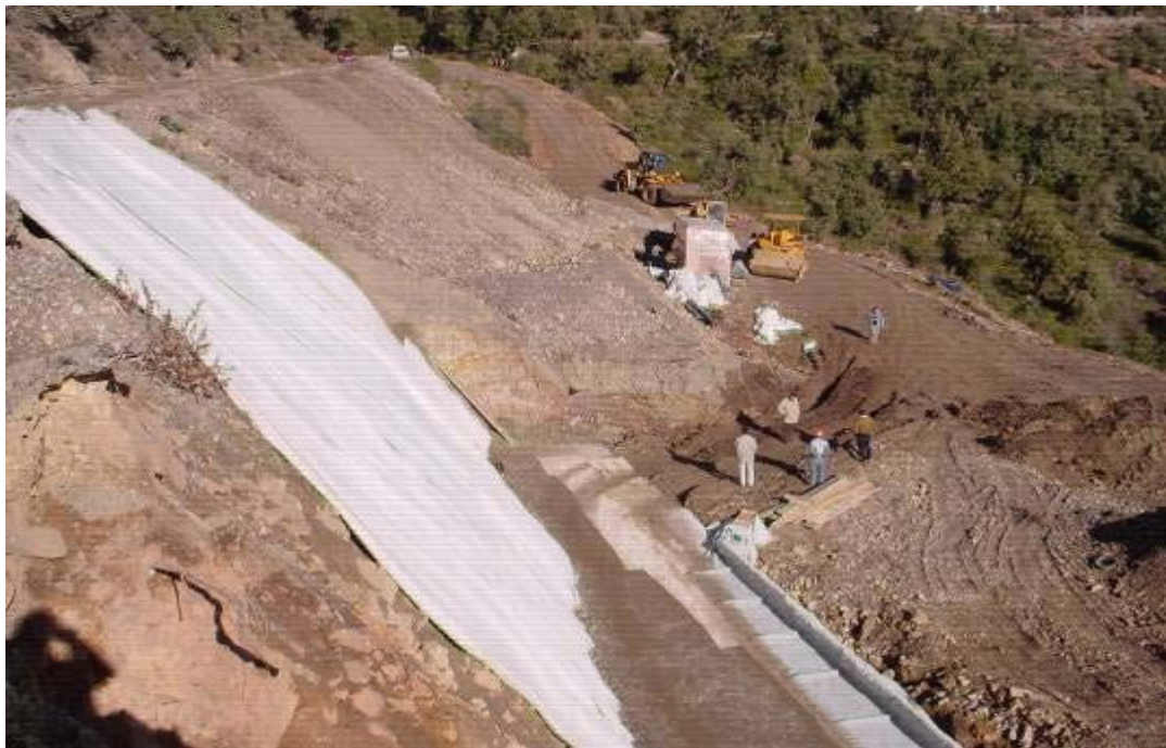
Figures 1.7a vues de l'ouvrage en cours de construction et achevé
