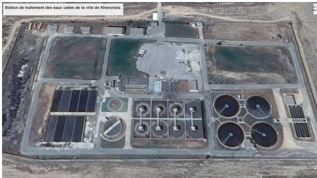
Figure 1: Aperçu général de la station d'épuration de la ville de Khenchela.
