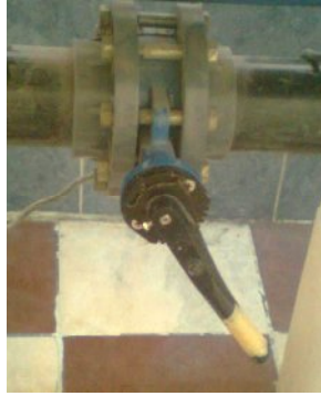
Figure 1.3 : Photographie de la boîte en charge et vanne de manipulation.
