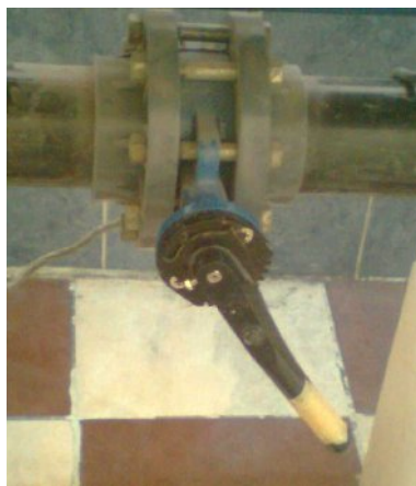
Figure 1.3 : Photographie de la boîte en charge et vanne de manipulation.
