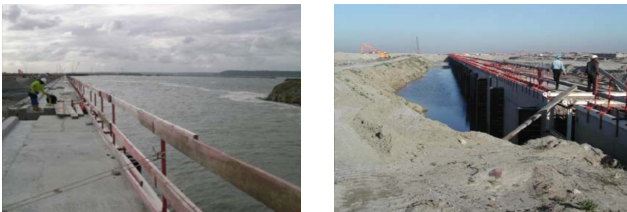
Figure VI.73. Situation en aval du quai (a) fin mai et (b) début juillet 2004. Photos © (a) Solétanche-Bachy et (b) CETE Normandie-Centre.
