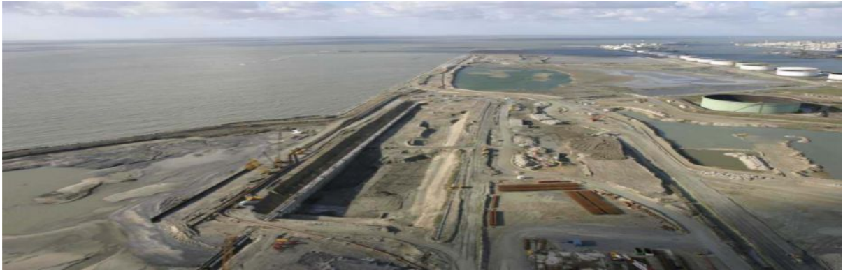
Figure VI.67. Vue aérienne de la partie Ouest du chantier. Photo prise au début de l'année 2004. © PAH, 2004
