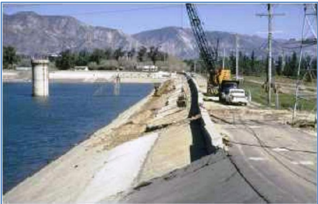
Figure 1.36 : Barrage supérieur de San Fernando après le séisme de 1971. [27]
