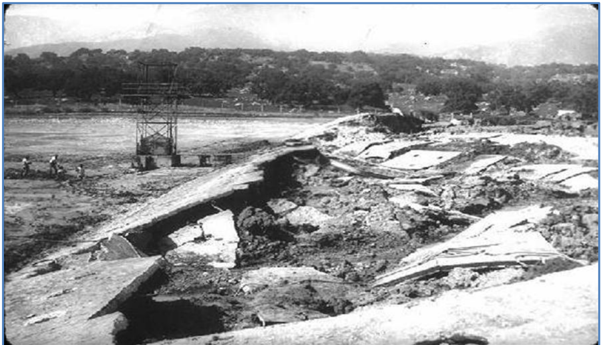
Figure 1.37 : Rupture du Barrage de Sheffield de Santa Barbara.
