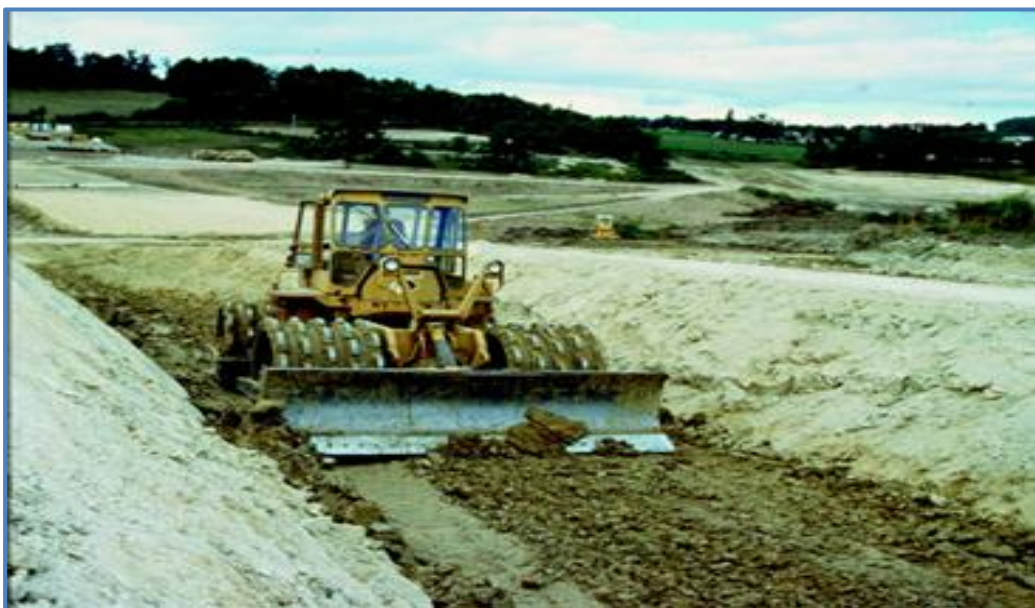
Figure 1.19 : Compactage d'argile dans la clé d'étanchéité.
