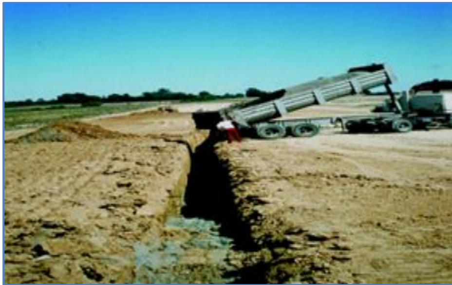
Figure 1.21 : Drain vertical recreusé dans le remblai et remplissage par du sable drainant et autofiltrant.
