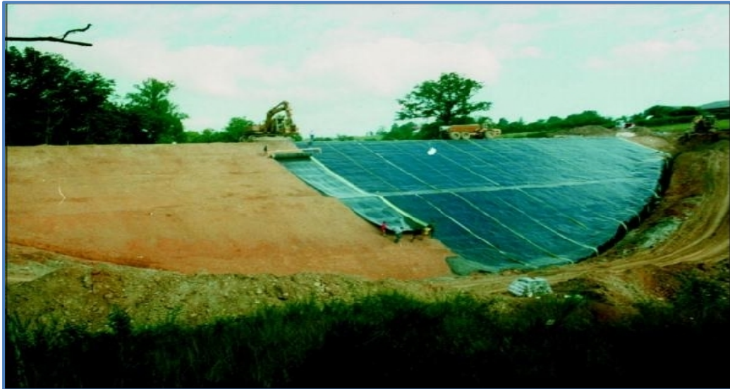
Figure 1.23 : Mise en place d'une géomembrane.
