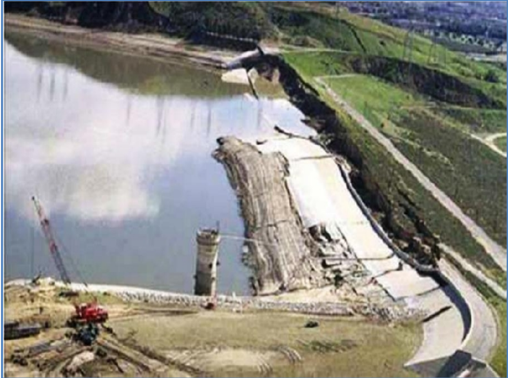
Figure 1.35 : Barrage inférieur de San Fernando après le séisme de 1971. [27]
