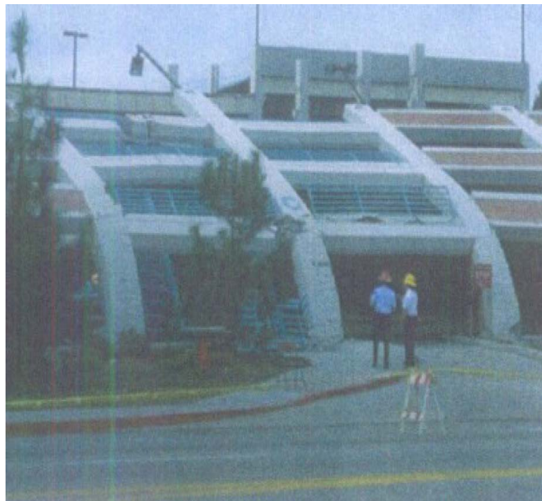
Figure III.21 : effondrement par flexion hors plan d'une structure portiques en béton armé (Parking) lors du séisme de Northridge (Etats-Unis) en 1994.
