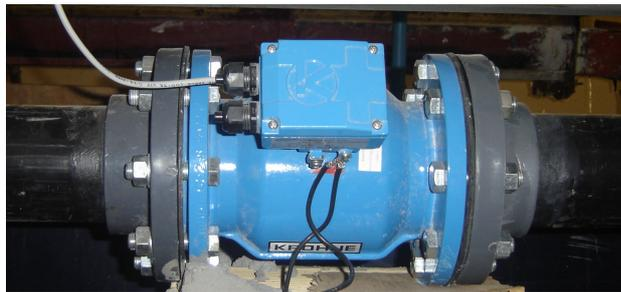
Photo 5.3 : Photographie du capteur de mesures du débitmètre électromagnétique.
