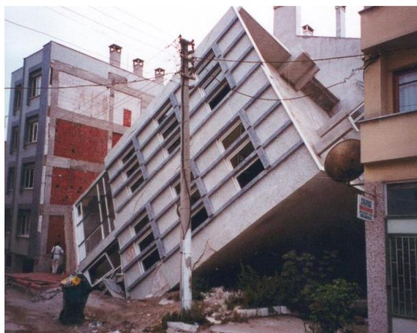
*Figure 1.21 renversement d'une structure sous l'effet de la liquéfaction séisme Turquie 1999 (d'après Peter M. Byrne et al, 2008).*
