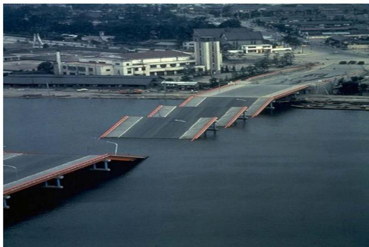
*Figure 1.4 : Rupture du pont de Showa, à Niigata au Japon, dues à l'épandage latéral dans le sol (d'après Peter M. Byrne et al, 2008).*
