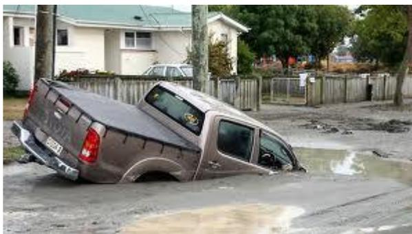
**Figure 1.26 :** Un véhicule enlisé dans la liquéfaction, après le tremblement de terre à Christchurch, New Zealand (2011)
