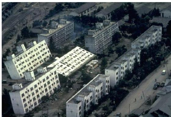
**Figure 4.22** renversement des structures sous l'effet de la liquéfaction à Niigata 1964 (d'après Peter M. Byrne et al, 2008).
