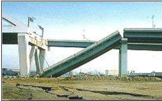
**Figure 1.11 :** Endommagement des ponts : Un tel dommage peut avoir des conséquences désastreuses, empêchant même les opérations de sauvetage. Les mouvements induits par la liquéfaction peuvent pousser les bases hors du point où le pont enjambe l'appui, dans ce cas le pont lâche (d'après Jorgen Johansson, 2000).
