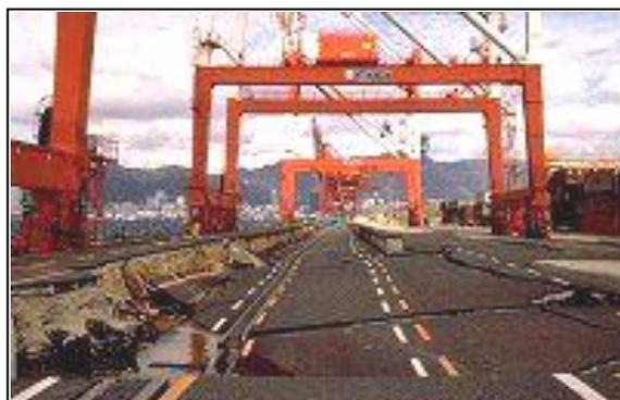
*Figure 1.10 : Glissement de murs de quai : Lorsque le sol derrière et/ou sous un tel mur se liquéfie, la pression qu'il exerce sur le mur augmente considérablement et fait glisser ou/et incliner celui-ci, (d'après Alisha Kaplan, 2004).*
