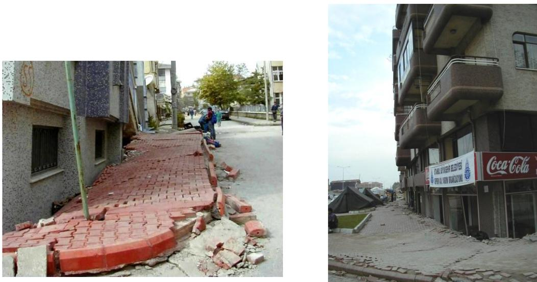
*Figure 1.20 Poinçonnement de la fondation sous la liquéfaction séisme Turquie 1999 (d'après Peter M. Byrne et al, 2008).*
