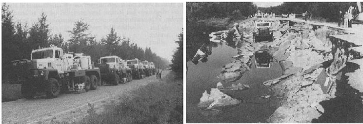
**Figure 1.6** rupture de remblai sur le lac Ackermann déclenché par camions de vibroseis (de Hryciw et al, 1990.
