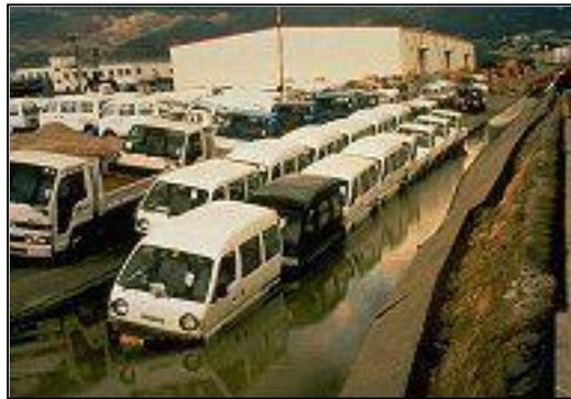
**Figure 1.12 :** Endommagement des routes : Baisse du niveau de la route due à l'épandage latéral (d'après Alisha Kaplan, 2004).
