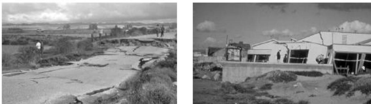
*Figure 1.8 : Epandage latéral le long de la route Sandholdt (à gauche) et destruction d'un centre de recherche (à droite) à Moss Landing. (D'après le Earthquake Engineering Research Center, University of California, Berkeley; Elgamal et al, 2001)*
