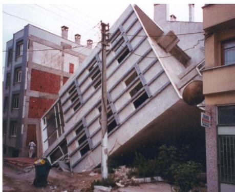
**Figure 4.23** renversement d'une structure sous l'effet de la liquéfaction séisme Turquie 1999 (d'après Peter M. Byrne et al, 2008).
