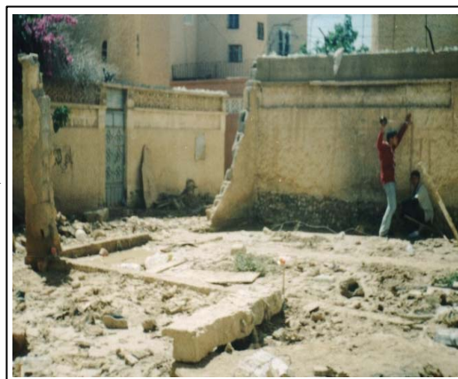
PhotoV.1: Effondrement d'un mur de clôture réalisé en parpaings creux de 20 cm d'épaisseur.
