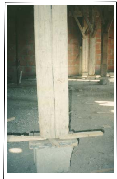
Photo V.10: Etai sur parpaing creux considéré comme support fragile.
