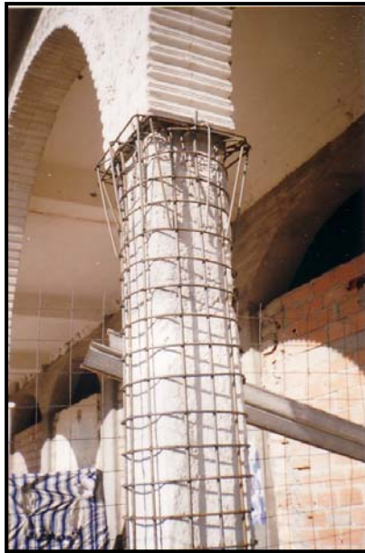
PhotoVII.2: Chemisage d'un poteau en béton armé
