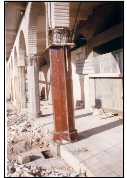
PhotoVII.3: Opération de coffrage du poteau
