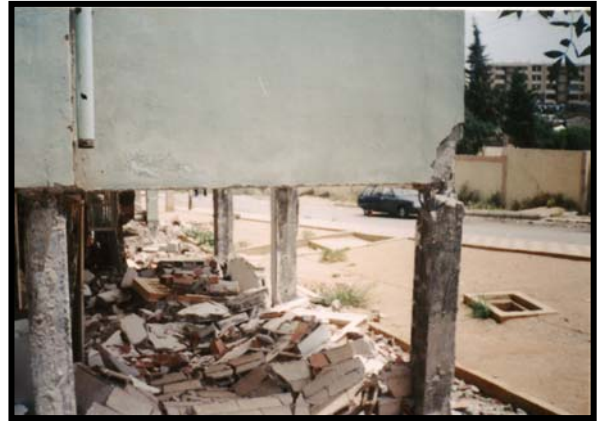
PhotoV.24: Pas d'anomalies sur la poutre de rive
