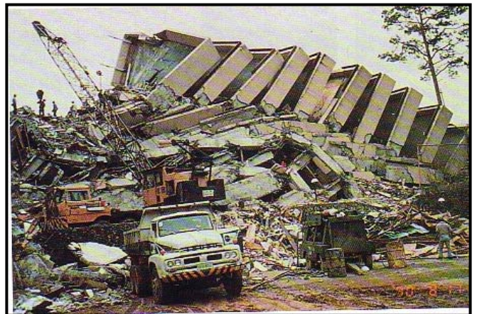
PhotoV.37: Effondrement d'un hôtel (séisme: 1990, Philippines) [1*].
