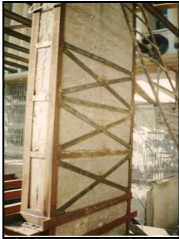
PhotoVII.8: Gainage d'un poteau en béton armé
