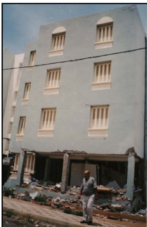
PhotoV.17: Bâtiment avec poteaux, poutres Et mur en maçonnerie (niveau:R+3)
