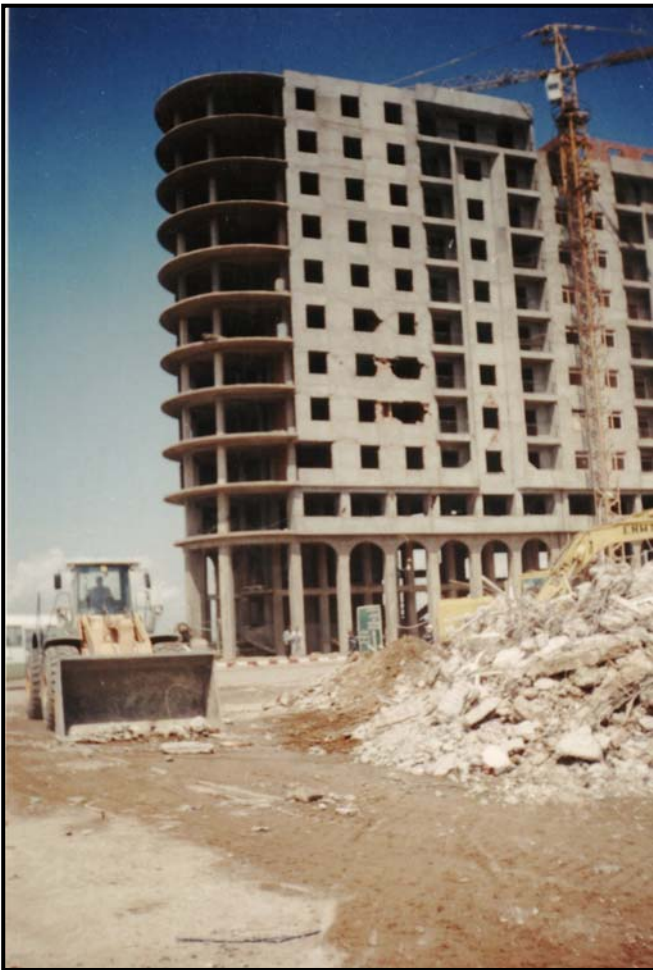
PhotoV.32: Bâtiment en cours de construction, très bonne résistance au séisme
