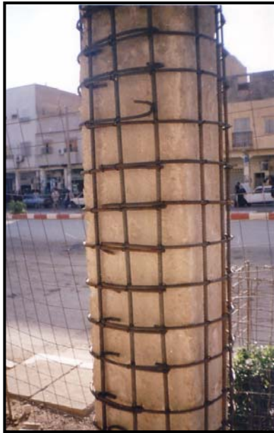
PhotoVII.1: Chemisage d'un poteau en béton armé
