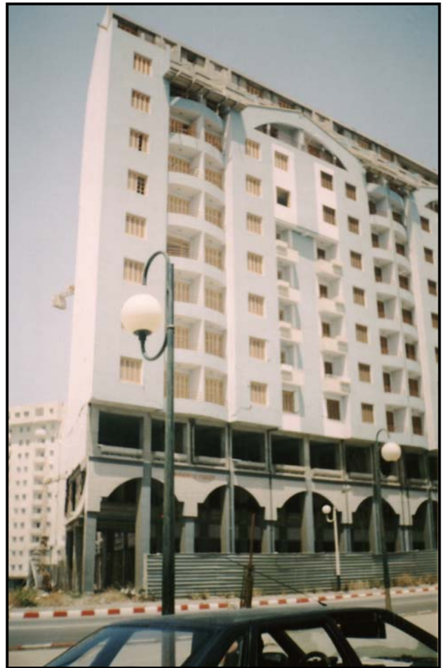
PhotoV.33: Bâtiment sans aucun dommage
