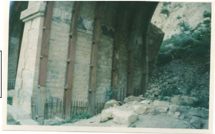
PhotoVII.15: Ensemble de profilés métalliques placés contre le parement en maçonnerie permettant la transmission des charges au sol de fondation. El-Kantara (Biskra).
