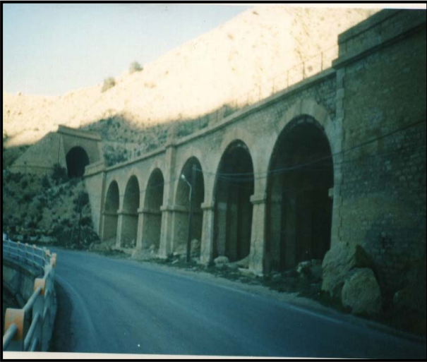
PhotoVII.14: Une série de voûtes servant comme support de la voie ferrée à El-Kantara (Biskra).
