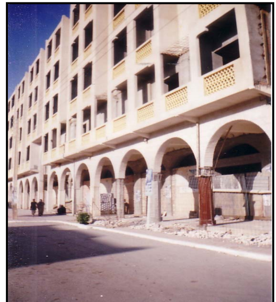
PhotoVII.5: Hôtel où les travaux de chemisage des poteaux ont été effectués
