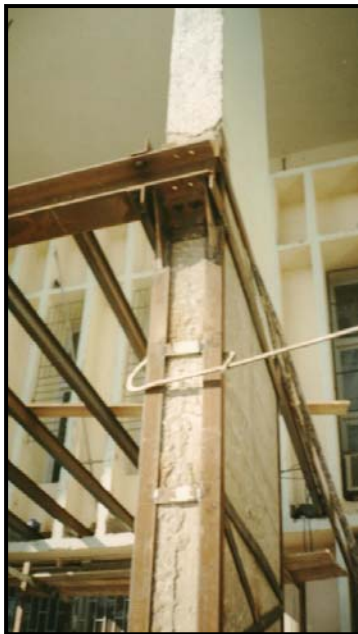
PhotosVII.11: Gainage d'un poteau d'angle
