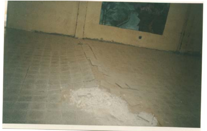
PhotoVI.10: Pulvérisation du béton
