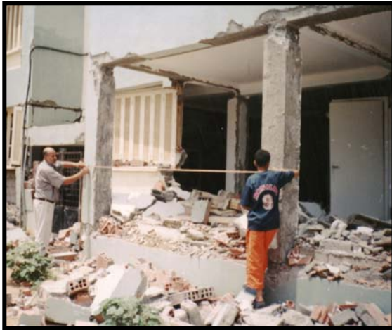
PhotoV.19: Distance entre axe des poteaux égale à 3.40 m.
