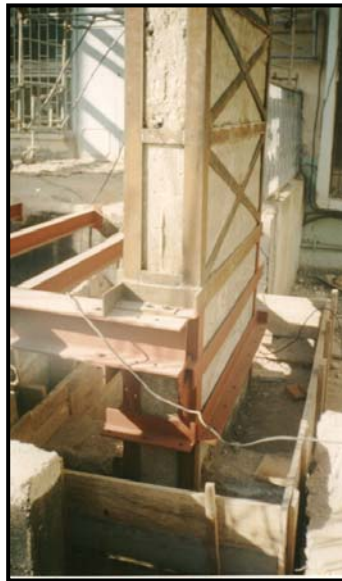
PhotoVII.9: Coffrage de la semelle
