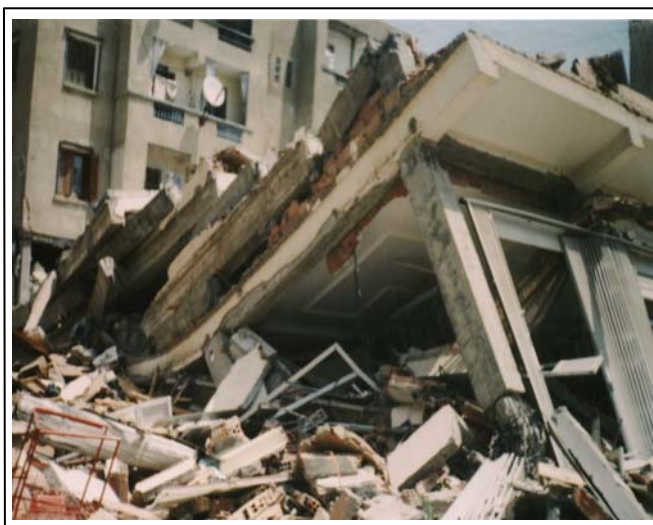
Photo IV.6: Effondrement totale d'une construction de niveau R+3
