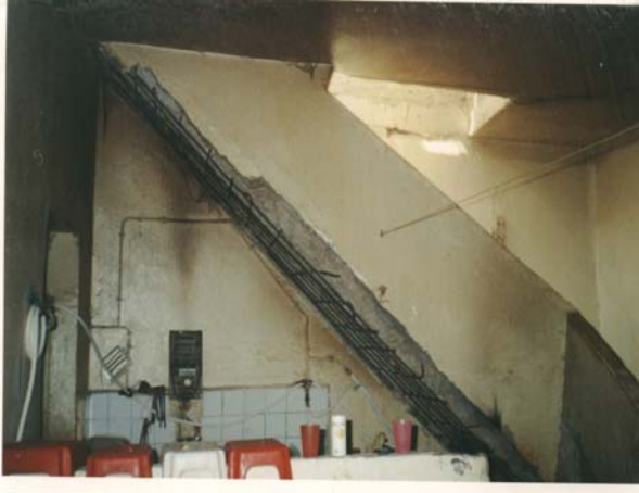
PhotoVI.7: Paillasse d'escalier vue de profil
