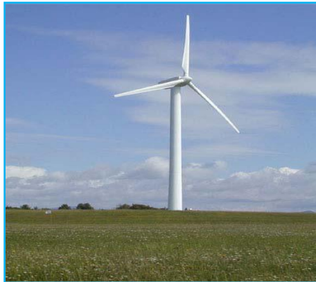
Fig. II.5 Turbine éolienne à horizontal 'rapide'
