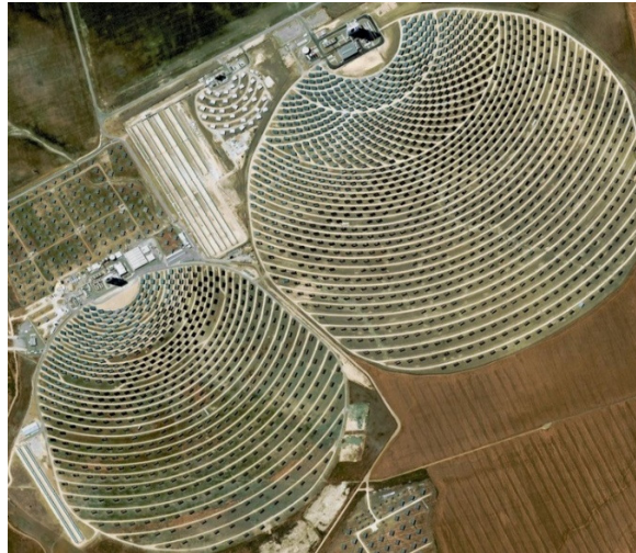
Figure 1.18. Les deux centrales commerciales PS10 et PS20 (Espagne), avec des héliostats de 120 m 2 .
