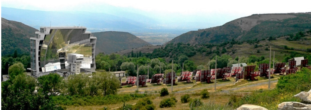
Figure 1.13. Le four solaire français de 1 MW à Odeillo employant un champ de 63 héliostats de 45 m 2 chacun [13].
