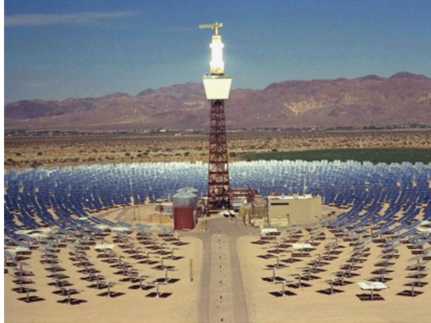
Figure 1.15. La centrale solaire Solar Two près de Barstow, en Californie.
