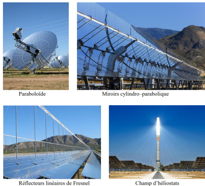
Figure 1.9. Concept de base des quatre familles CSP (de gauche à droite et de haut en bas) : parabolique (Dish), cylindro- parabolique, miroir Fresnel, tour solaire [1].
