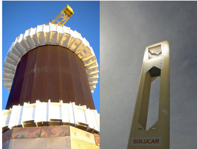
Figure 1.12. Deux exemples de récepteurs pour la tour solaire : (à gauche) le récepteur externe, (à droite) le récepteur à cavité, [29].
