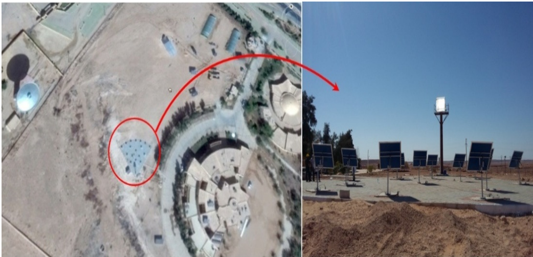
Figure 4.1. La mini tour solaire réalisée à l'unité de recherche appliquée en énergies renouvelables (URAER) située dans le sud de l'Algérie, à environ 600 km au sud de la capitale.
