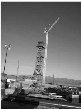
Figure 1.20. L'installation de la tour solaire (110 MWe) par BrightSource à Ivanpah près de Las Vegas, janvier 2012 [13].
