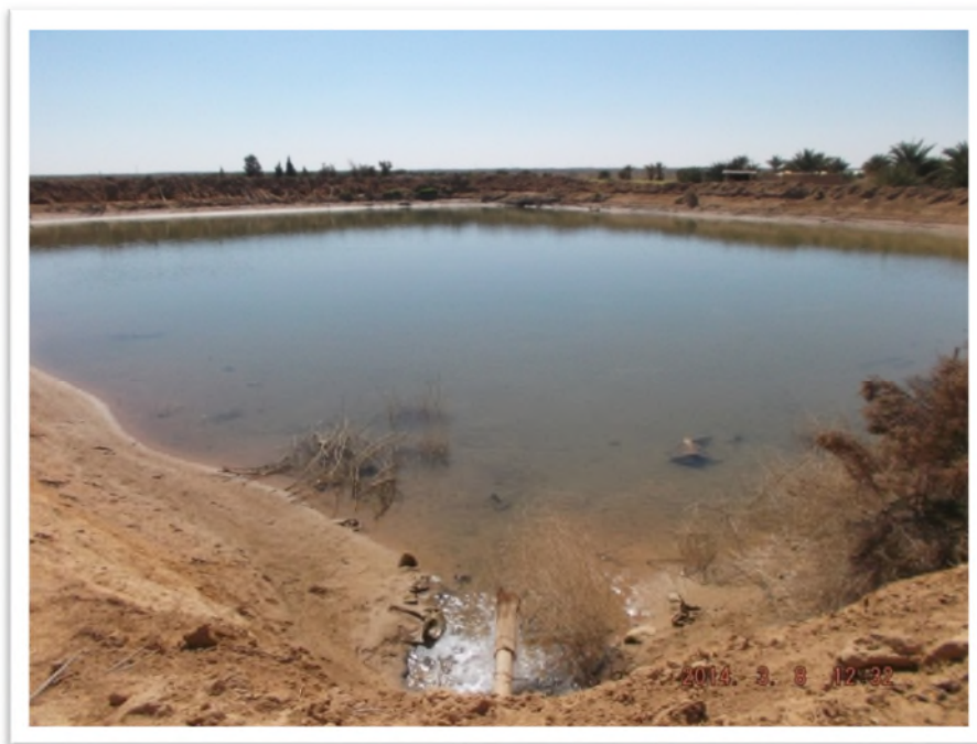
Photo01 : Bassin traditionnel d'accumulation des eaux de forages utilisées à l'irrigation des terres agricoles dans la région de sidi Okba. (Auteur, 2014).
