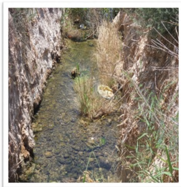
Photo04 : Drain principal BBA (palmeraie de Laejal) qui collecte les eaux de drainages de Ghadar vers Ezarga. (Auteur, 2014).
