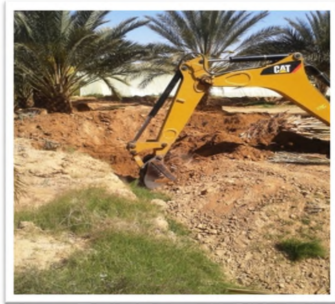
Photo 07b : Des travaux importants réalisés par le fellah afin de planter les jeunes palmiers dont le but de briser la couche argileuse et placer le palmier sur la couche sableuse (70-150 cm, selon les profils) dans la région de Sidi-Okba (Tajdid).
