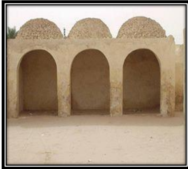
صورة 13 : "البرطال" ، أحد المرافق الضرورية في البيوت الصحراوية القديمة التي جابهوا بها الحرارة
