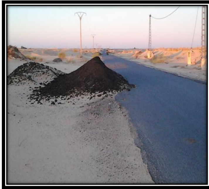
صورة 30: وضع الاسمدة على حافة الطريق بشكل يهدد سلامة
