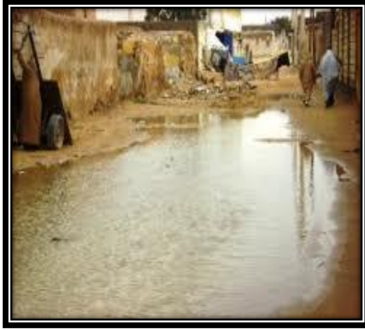
صورة 4: حالة الشوارع أثناء تفاقم المشكلة
