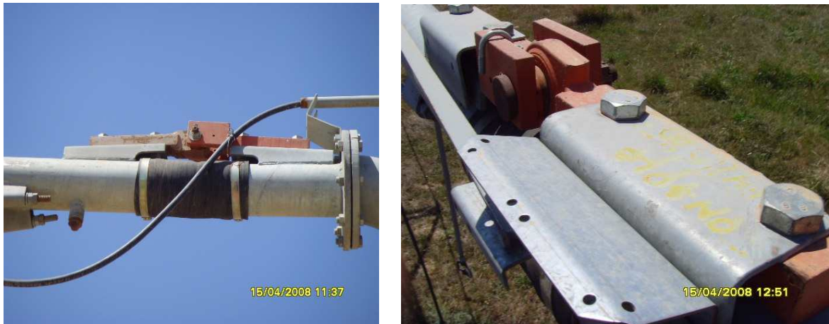
Fig.1.19 Jonctions articulées entre éléments de rampe pivotante par cardon intérieur et manchon à rotules métalliques
