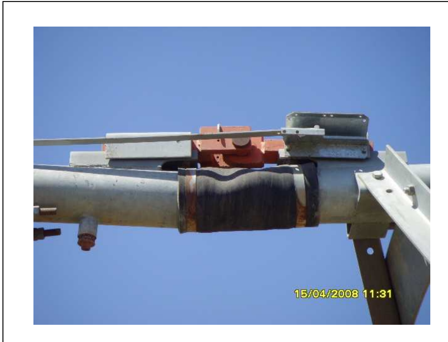
Figure 1.15: Elément de liaison entre travée, Photo IRRAGRIS.
