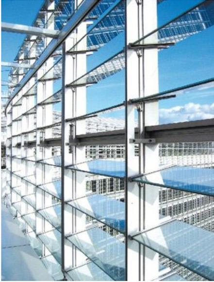
**Figure I.63 : Bâtiment Berlaymont équipé de Double facade composée de lamelles de verre mobiles**
