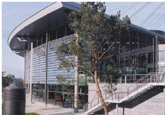
**Figure I.65: Brise soleil à lames de verre en position entièrement fermée**
