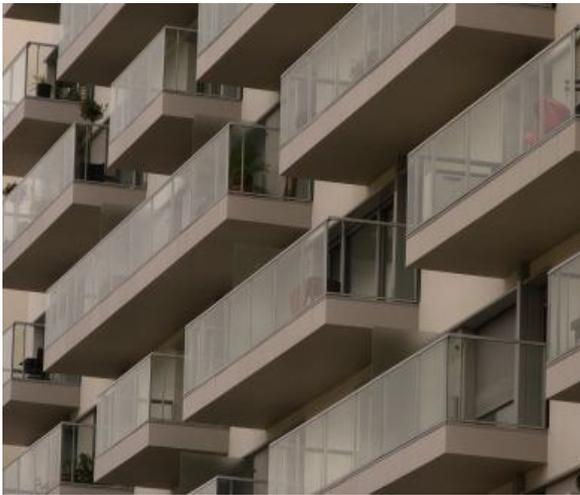
**Figure III.13 : Les balcons, element d'ombrage**
