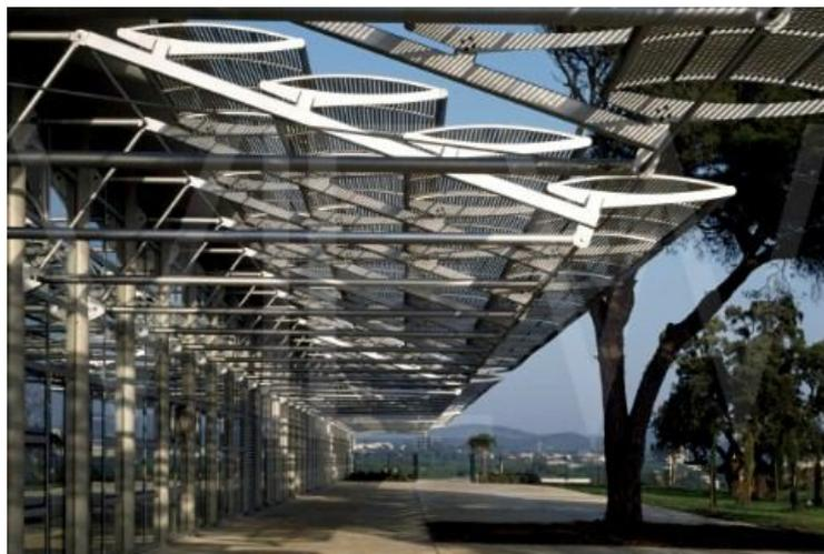
**Figure I.55 : système de protection solaire, Lycée Polyvalent de Fréjus en France,**
