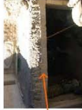
Renforcé la sqifa d'un portique
