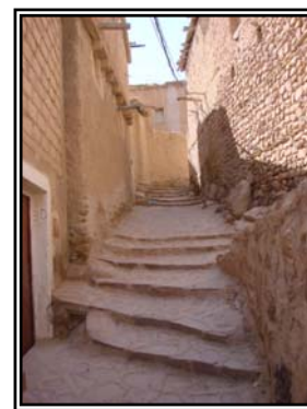
Photo14 : Ruelle avec escalier Source : auteur 2009
