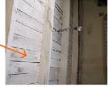
remplacement du bois de toiture
