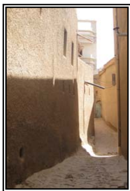
Photo12 : Ruelle interne Source : auteur 2009
