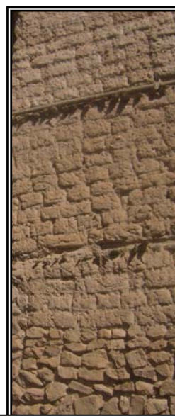
Photo 27 : Technique de construction de mur Source : auteur 2009
