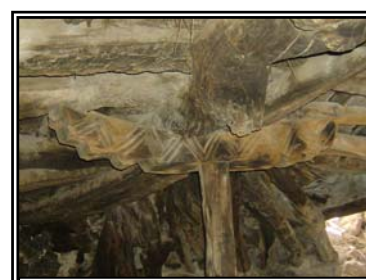
Photo 26: Poteau avec semelle Source : auteur 2008
