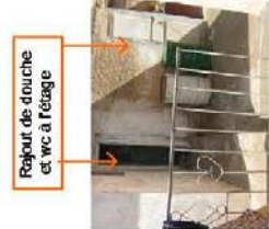
Altération de la façade après transformation. L'extension verticale par rajout de pièce, douche et wc à l'étage. Superposition ancien/nouveau
