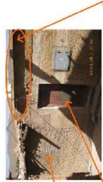
Crépissage du mur de façade avec un mortier de ciment
