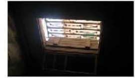
Changement de fenêtre + grillage
