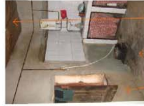
Revetement crépissage et couverture du toit avec du carton de frange partie
