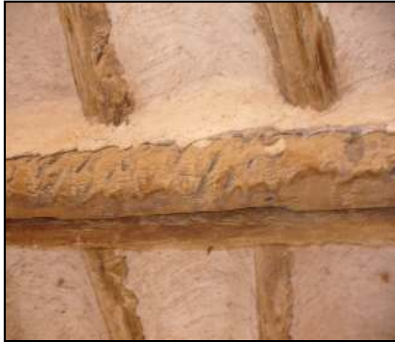
الصورة (3-1): طرق الإنشاء بقصور غرداية.
