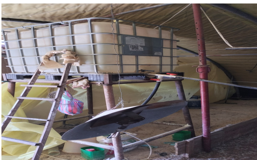
Figure 19. Installation d'eau de boisson avicole (photo originale).
