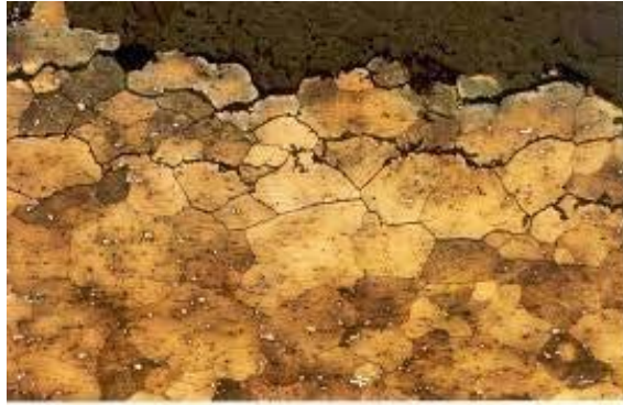
Fig I.7: Corrosion sous contrainte
