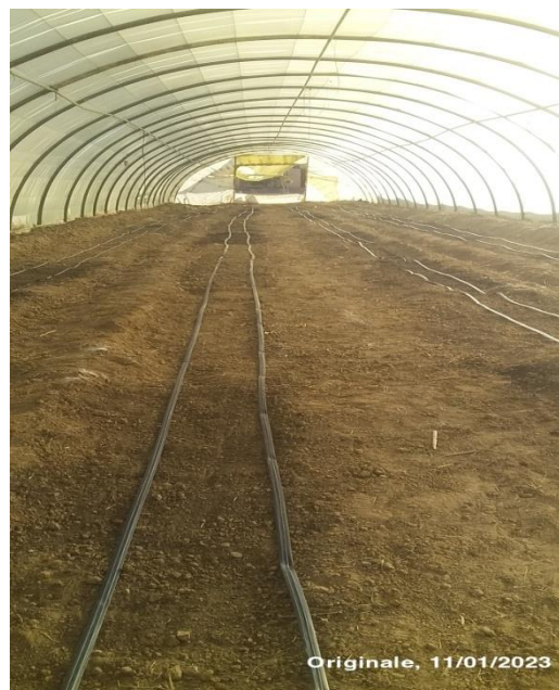
Figure 18 : Installations des gaines gouttes à gouttes
