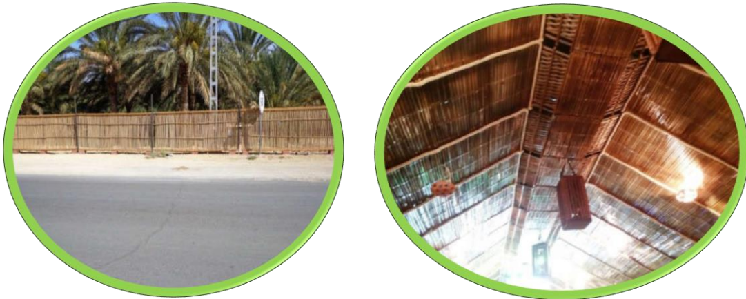
Figure 27 : Clôture à base de rachis de palmes Figure 28 : Faux plat fond ((Yacine et al.,2017)
