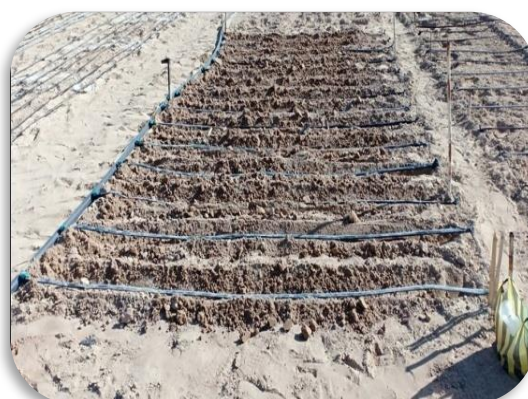
Photo 5 : mise en place du réseau d'irrigation
